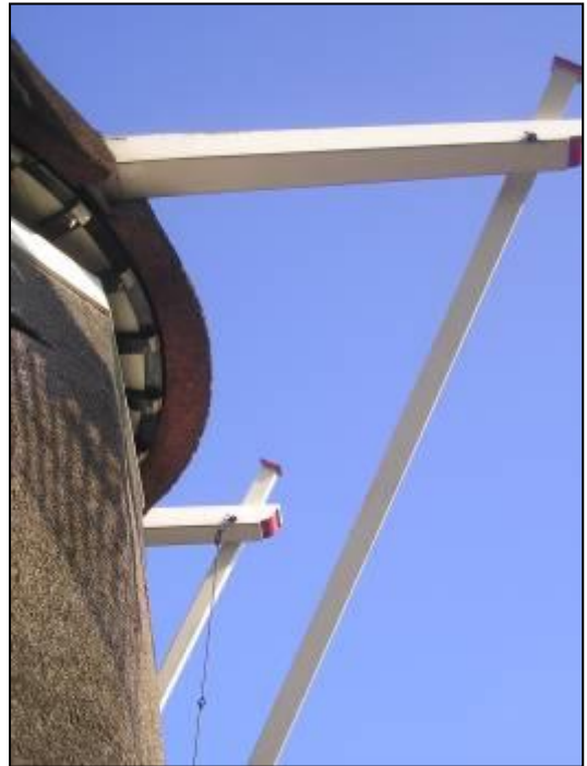
duw en trekwerk door schoren
