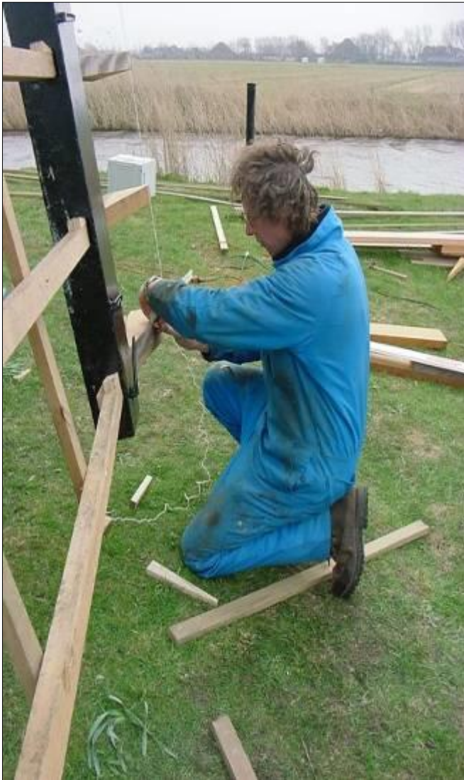
het maken van nieuwe kluften
