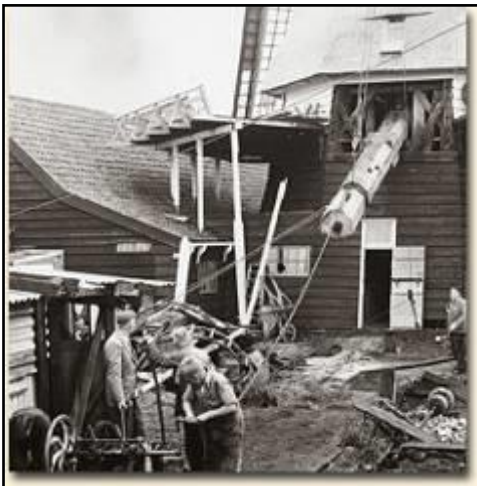
"Even" een nieuwe wentelas installeren (De Ooievaar)
