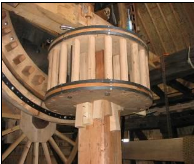
schijfloop in opbouw (afgebrande molen C)
