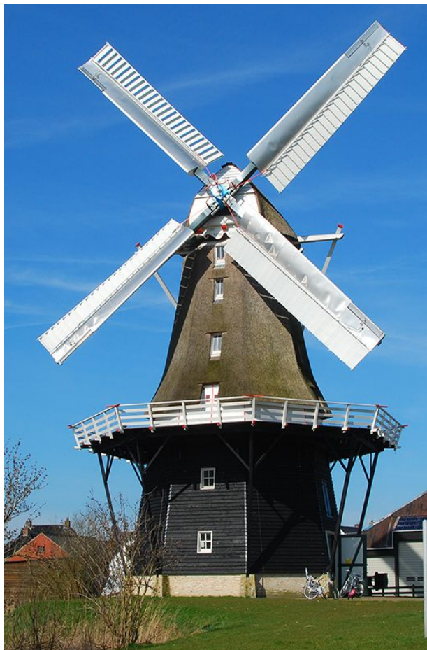
Klassieke Dekkerwieken (gedekt) met zelfzwichting Windlust, Burum Fr.
