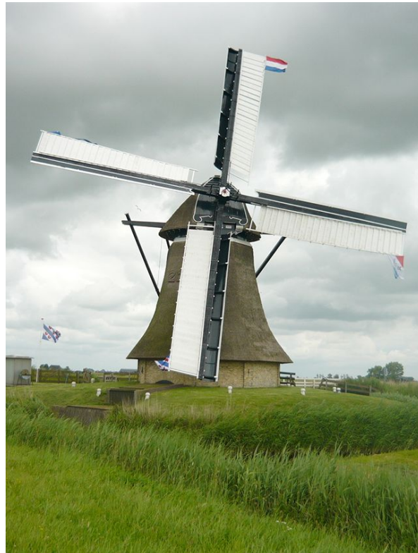
Zelfzwichting met Fauël op staande roe en oud-hollands bord op liggende roe. Aylvapoldermolen, Burgwerd Fr.
