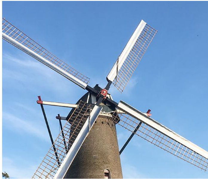
Wieken voorzien van het systeem Van Bussel. Om zeilslag tegen te gaan zit er minder schoot of zeeg in de hekken dan normaal. Aalstermolen in Aalst
