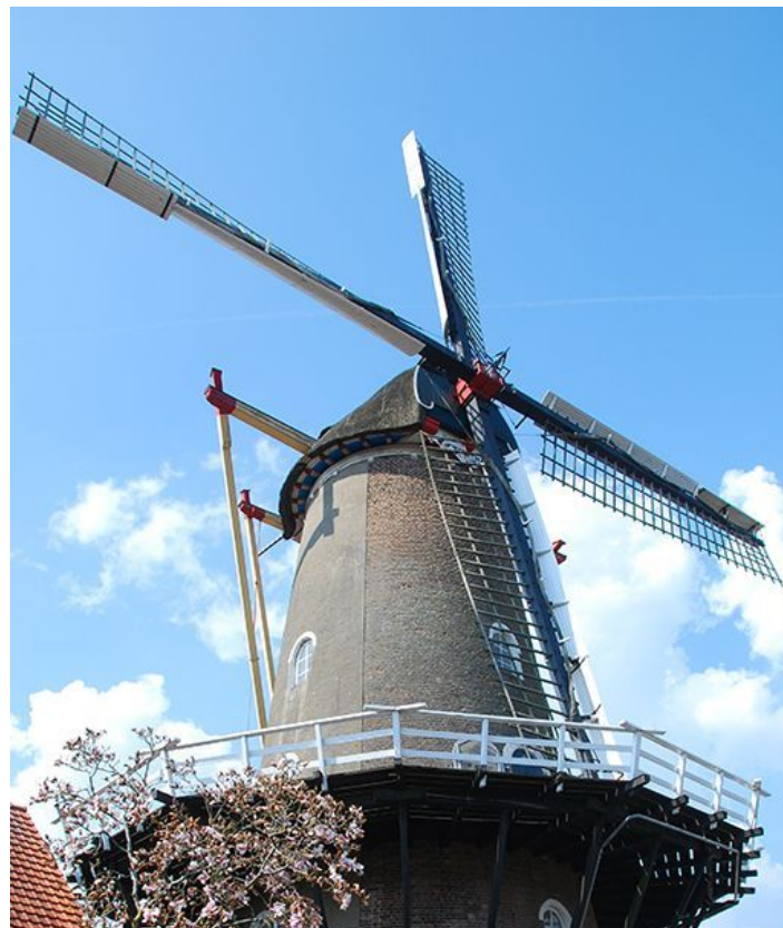
Systeem Fauël met remkleppen die bij de staart bediend worden. De Vlijt, Wageningen
