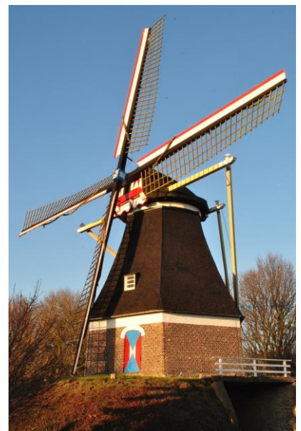
Een zeskante beltmolen op een stenen voet. Het zeskant is gedekt met schaliën. Mariamolen – Haps
