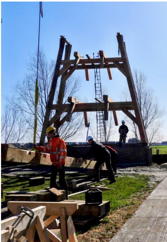
De twee vaste gebinten staan op het ondertafelement. Dwars op de vaste bintbalken liggen al de losse bintbalken en de korbelen 'hangen' er aan. (Foto: Hennie Boersma)
