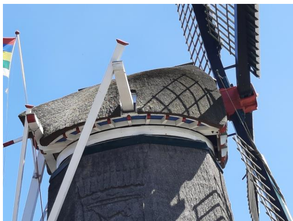
Een kap met middelbalk in plaats van lange spruit. De Koffiemolen – Midsland (Terschelling)
