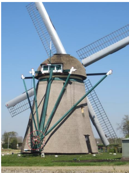
Een rietgedekt achtkant op een zeer lage stenen veldmuur. Hogeveense Molen – Noordwijkerhout
