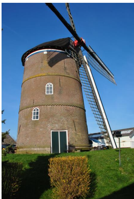
Een torenmolen, uitgevoerd als binnenkruier De Zwaan - Lienden
