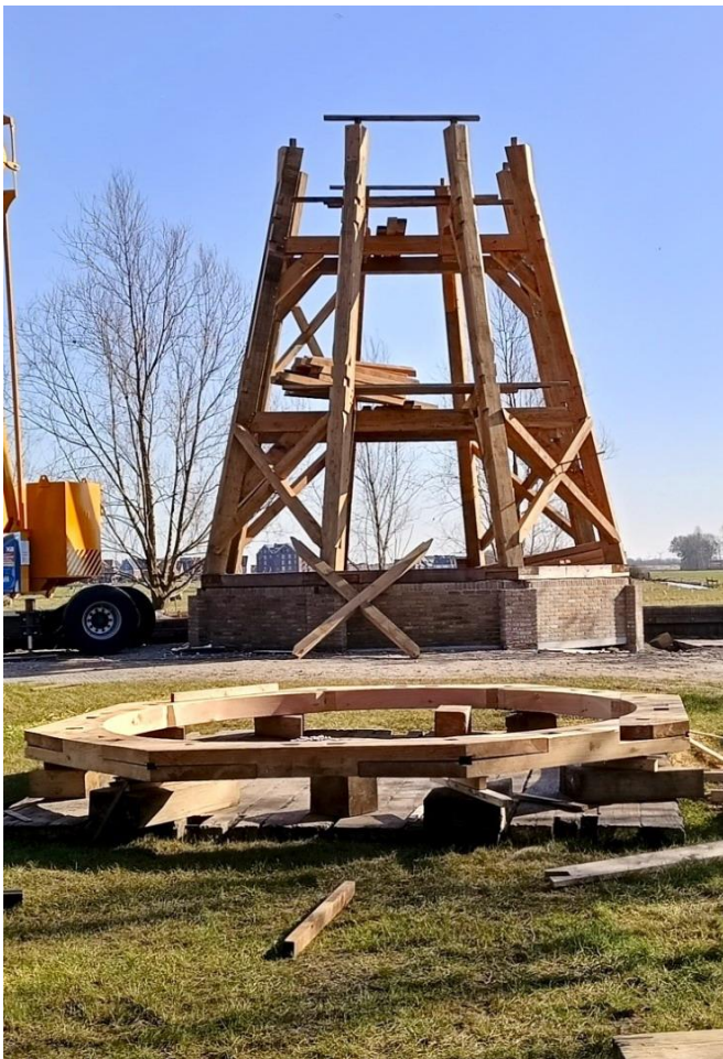
Nadat alle achtkantstijlen zijn geplaatst worden de veldkruisen aangebracht en volgt het boventafelement.
