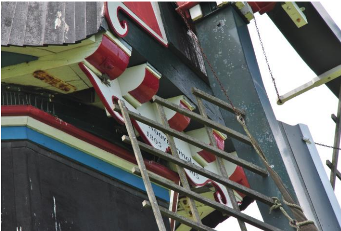
Tussen de steunder (burgemeester) en de voeghouten ook nog twee 'wethouders'. Noordermolen - Noordbroek
