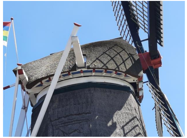
Een kap met middelbalk in plaats van lange spruit. De Koffiemolen – Midland (Terschelling)
