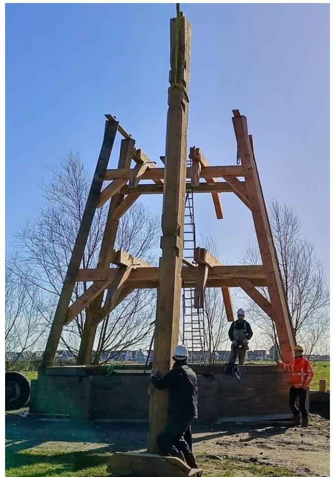
De overige vier achtkantstijlen worden geplaatst. In de stijlen zijn de inkepingen voor de houtverbindingen al aangebracht. (Foto: Hennie Boersma)
