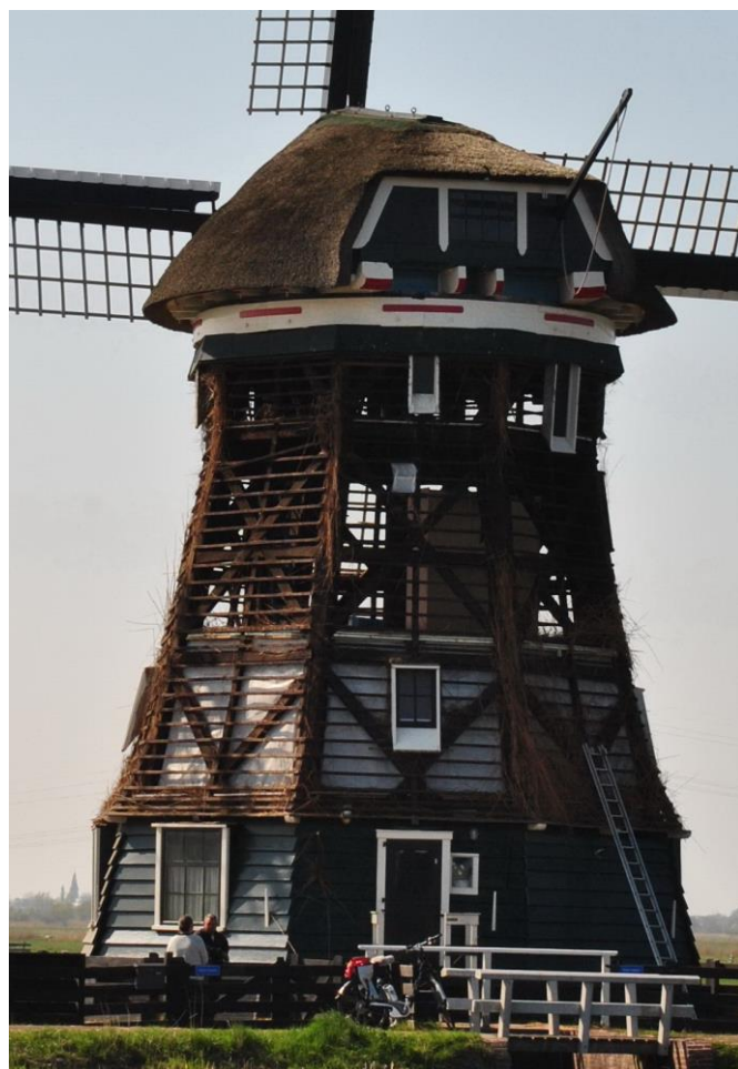
Het onderste deel van dit achtkant – de weeg – is bedekt met gepotdekselde planken. In de velden zien we de rietlatten. De Woudaap – Krommenie
