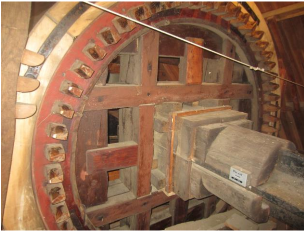
Een bovenwiel met extra stutten tussen kruisarmen en plooistukken. De vulstukken zijn deels afgerond.
