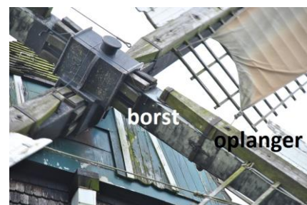
Een borstroede. De askop en borst zijn van ijzer, de oplangers van hout.
