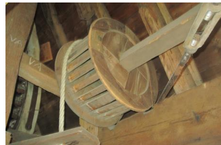
Een trommelvang. Om de trommel ligt het vangtouw. Rechts de as voor de binnenvangketting. Standerdmolen - Mierlo
