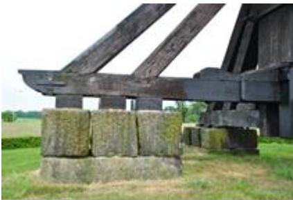
Teerlingen van zandsteen, zonneblokken, kruisplaat en steekbanden.
