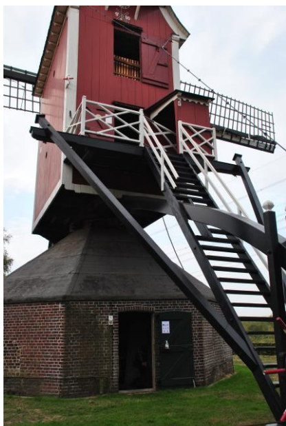
Trapbint met galerij, trapschoren vanaf de spruitbalk, staart en hangbomen. Molen St. Lindert - Beegden
