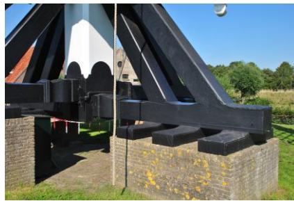
Gemetselde teerlingen, zonneblokken, kruisplaten, standerd en steekbanden.
