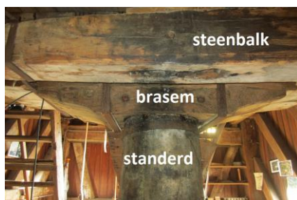
Het bovenste draaipunt. Tussen de steenbalk en de standaard de brasem. Standerdmolen – Mierlo
