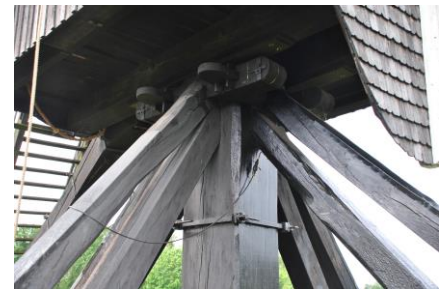
Vier paar steekbanden, standerd en zetel. De borst is gedekt met schaliën.
