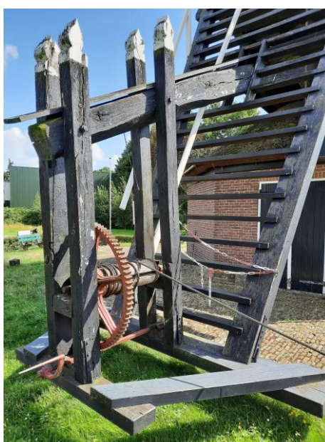
Trap met kruibank, staart, twee hangbomen, twee nonnen en kruilier.
