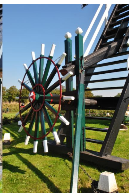
Trap met sleeptree, hangbomen, kruiwiel, bezetkettering en loopschoor.
