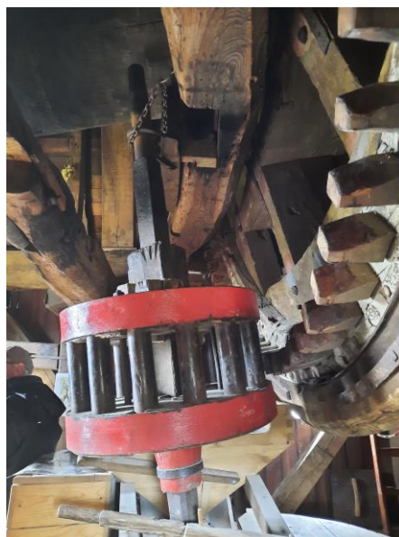
Het buslager is geopend om de voormolen uit het werk te zetten.
