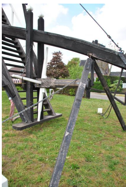
Trap met sleeptree, staart, twee hangbomen, kruihaspel en loopschoren.
