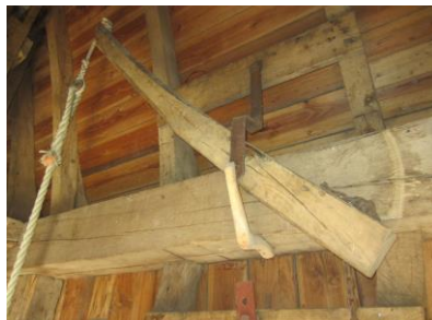
Een binnenvangstok. Links het vangtouw, rechtsonder de binnenvangketting. Daarachter de daklijst. Den Evert - Someren
