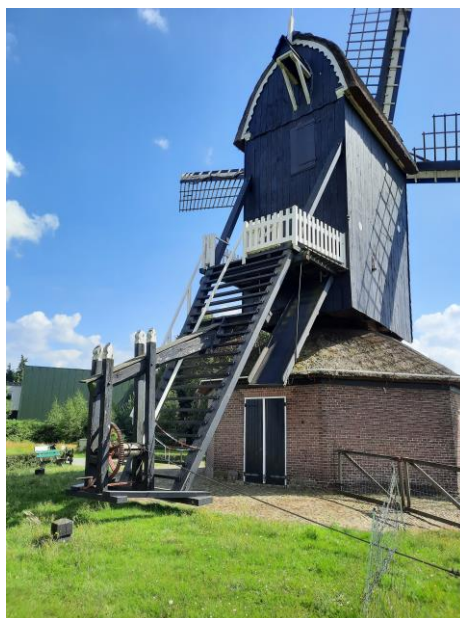
Trapbint met galerij, trapbomen aan de hoekstijlen. De trapschoren ontbreken. Den Olden Florus - Terschuur
