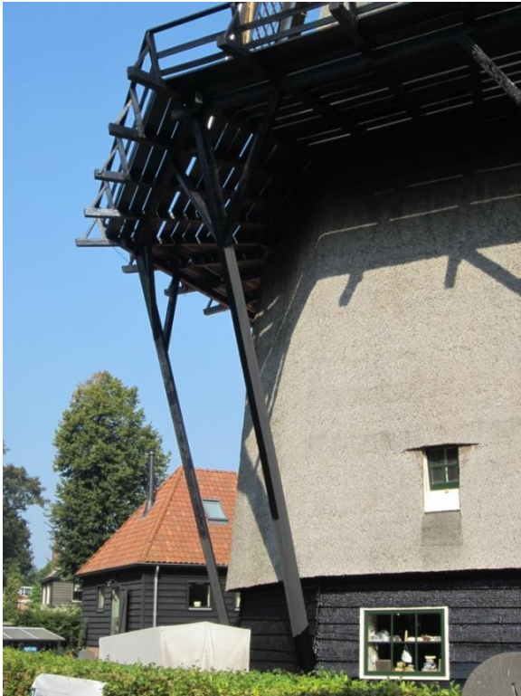
Afb.4.4 Een stelling om een rietgedekt achtkant op een rietgedekte onderbouw.
