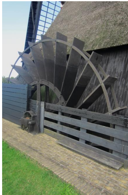
Een halfgesloten scheprad
