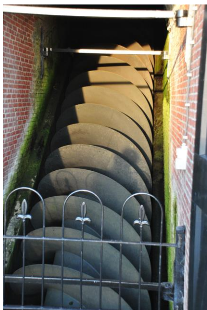
Een stalen vijzel. Lengte vijzelbalk ca. 12 m, diameter 1,32 m, lengte beschoeping 10,50 m en opvoerhoogte 4,5 m.
