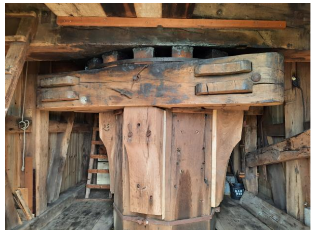
Een blik in het bovenhuis: we zien de koker met consoles en de bovenzetel.
