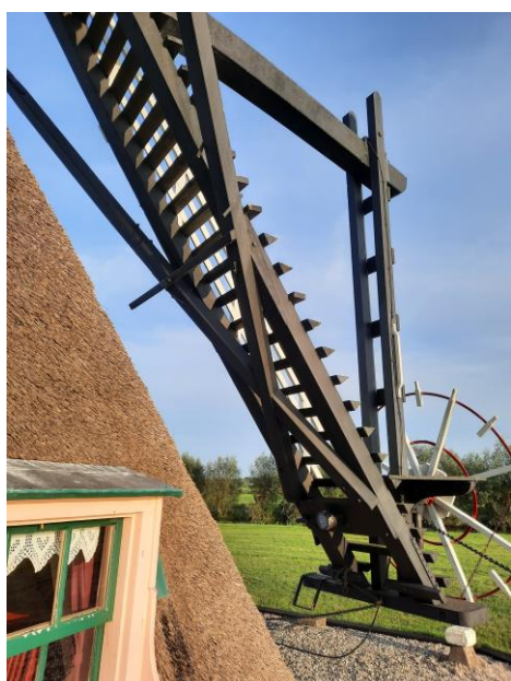
De staart met trap , trapbomen , slof en gekruipte trapschoren . Via de hangbomen hangt de trap aan de staart . Rechts een hoge kruibank .
