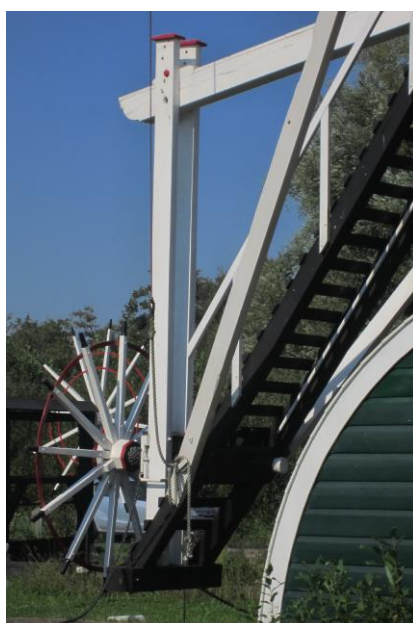
De staart met trap . De trapschoren zijn hier niet gekruipt .
