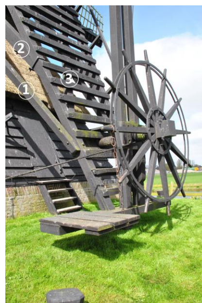
Trap met drie paar trapschoren . 1: van spruitbalk naar trapboom . 2: van waterlijst naar trapboom 3: vanaf achterzomer , gekruipt
