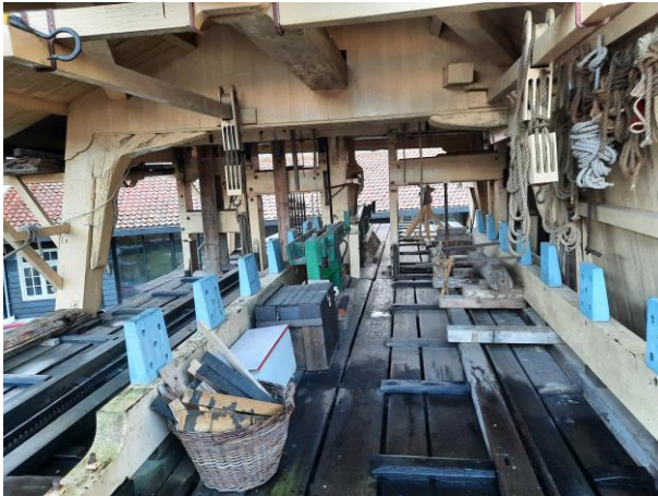
De zaagvloer vanaf de kraanzijde. Links en rechts boven de sleden de jijnrails met takelblokken. Naast beide sledes een schulpvloer. De Otter - Amsterdam
