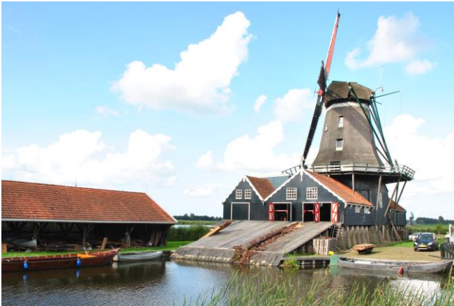
Het balkengat, de sleephelling en de grote toegangsdeuren verraden de houtzaagmolen. De Rat - IJlst
