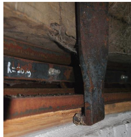
Een domphaak – hier bij een Engels kruierwerk. De haak grijpt onder een stalen plaat op de kruivloer.
