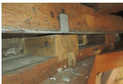
Enkele uitvoeringen van neuten; een oplossing tegen zwaar kruien is om in de neut een asje met schijven te bevestigen.
