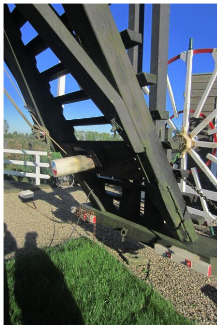
De munnik is gelagerd in twee brilplaten, één tussen de traptreden, de andere tussen de hangbomen.
