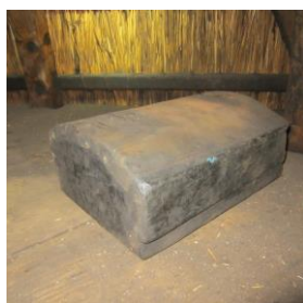
Enkele uitvoeringen van neuten; een oplossing tegen zwaar kruien is om in de neut een asje met schijven te bevestigen.
