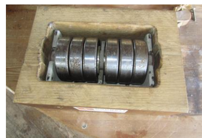
Enkele uitvoeringen van neuten; een oplossing tegen zwaar kruien is om in de neut een asje met schijven te bevestigen.
