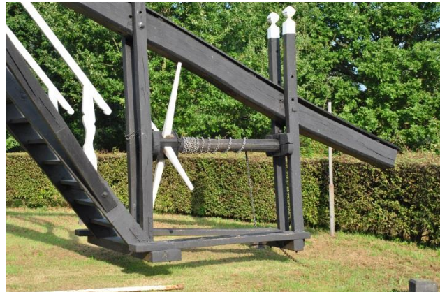
Een staart met hangbomen of kandelaar (links) en twee nonnen (rechts). Daartussen het kruihassel en de windas. Onderaan een kruibank.
