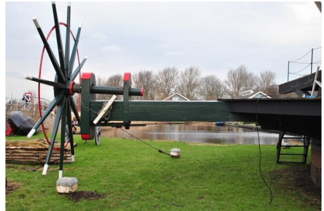
Door de grote lengte van de staart- of sleutelbalk levert deze een groot moment bij het krouen
