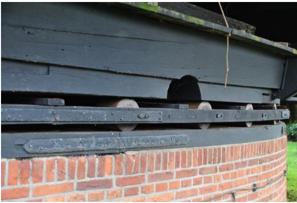
De paltrok. We zien de ringmuur met kruivloer en rollenwagens. Daarop de overring. Een kuip is niet nodig. In de overring is een uitsparing om kruitrollen te kunnen vervangen.
