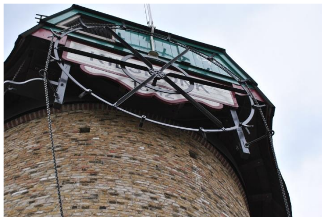
Een kettingkruierwerk met gaffelwiel en rondgaande ketting.
