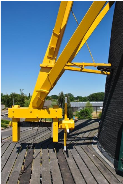
Een kruibok met kruiketting. Het haspel zit rechtsreeks op de kruias; niet lichter kruien dus. Let op de staartstut met staartrol!
