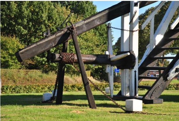
Een kruihassel met windas. De windas hangt tussen de hangbomen (wit) en de staartbalk. De staart is hier vastgezet met loopschoren en kettingen.
