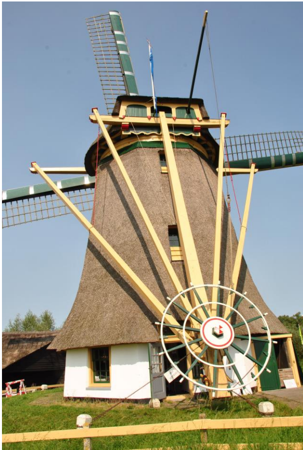
Een bovenkruier/buitenkruier met kruibare kap en staart. De staart bestaat uit de staartbalk, lange en korte spruit, lange en korte schoren en het kruiwiel.
