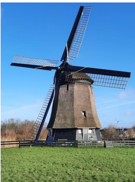
Strijkmolen C – Oudorp Een bovenkruier die vanuit de kap gekruid wordt: een binnenkruier
