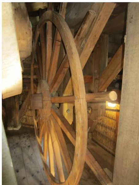
Een kruiwiel van een binnenkruier. Rechts twee kruipollen met schoren, links het bovenwiel.
