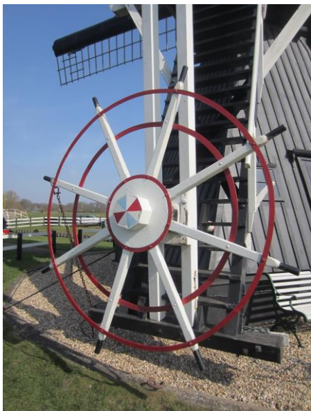
Een kruiwiel met dubbele gording.
