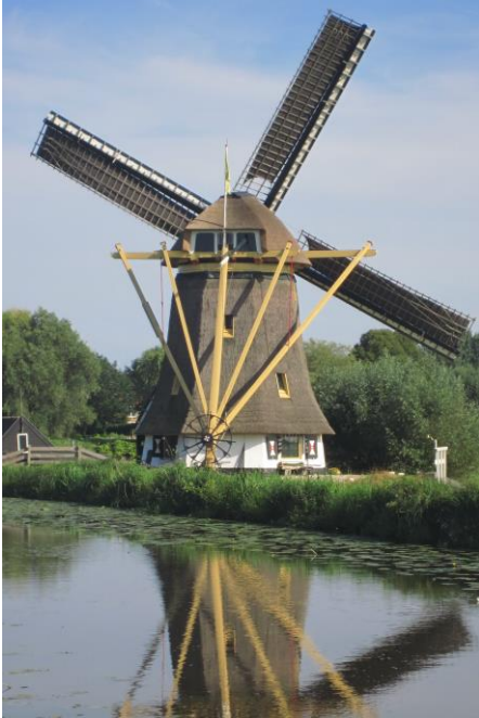
Hoog en Groenland – Baambrugge Een bovenkruier. Het bedienen van het kruierwerk gebeurt buiten de molen. We spreken dan van een buitenkruier.
