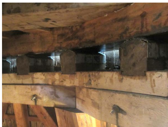
Een neutenkruiverk. Deze neuten zijn voorzien van blik.
