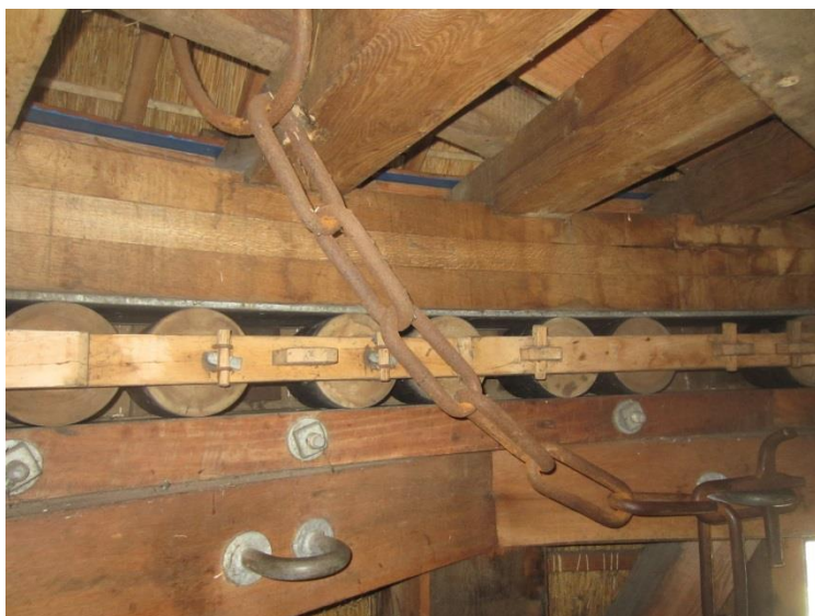
De doodketting, links bevestigd aan een balk op de roosterhouten, rechts aan een kruikram. Een schakel wordt over een kram geschoven en met een schotel vastgezet.
