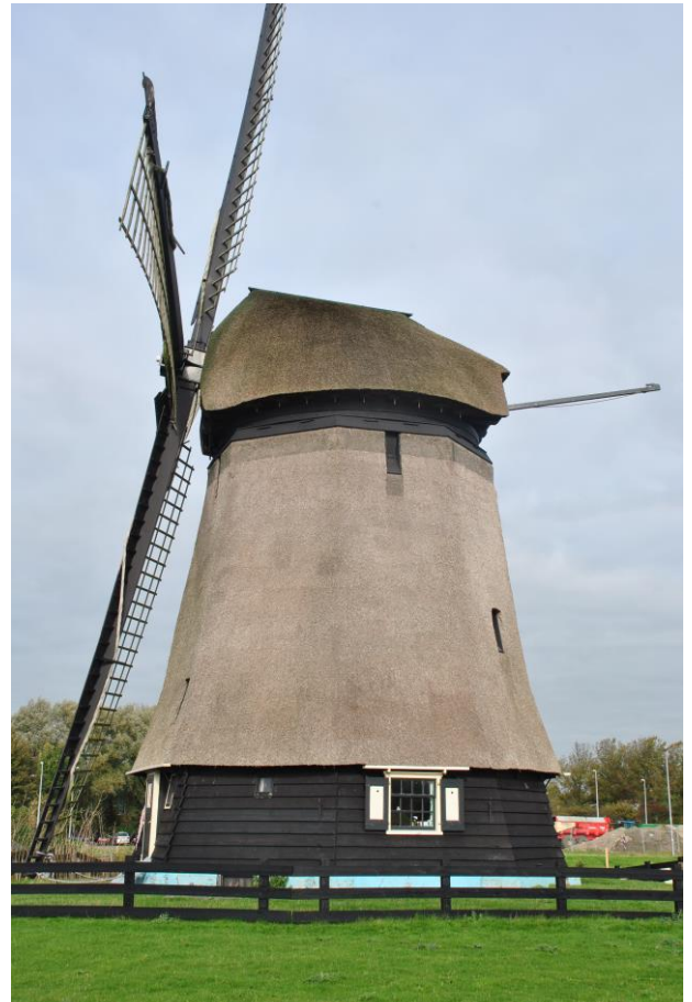
Een bovenkruier/binnenkruier. De staart ontbreekt, het kruiwiel bevindt zich in de kap. Ook kruipalen zijn niet nodig.
