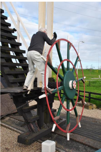
Een kruirad van een wipmolen. Kruien kan vanaf de kruibank of door in het rad te lopen.
