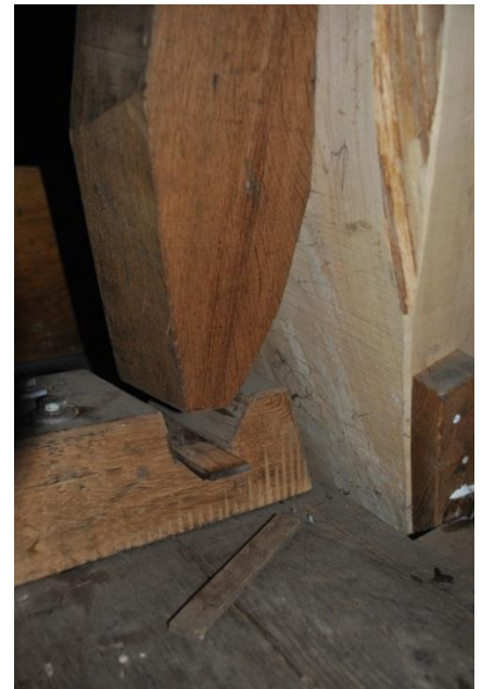
Afb.11 De rust en de rijklamp (of teen ) met enkele stelhoutjes . Hier bij opgelegde vang. Rechts het teenstuk .
