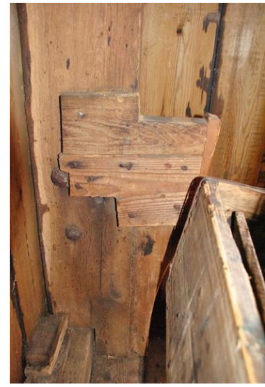
Afb.18 Achterste hanger met klamp . Rechts de ballastkist.
