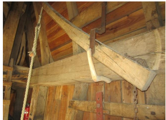
Afb.15 Binnenvangstok ; links het vangtouw , rechts de binnenvangketting
