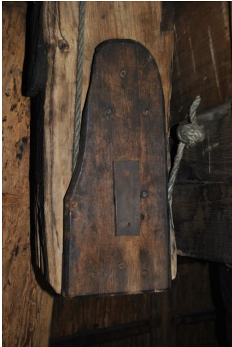
Afb.21 De trekvang , aan de achterste hanger Rechts de bevestiging van het touw aan de vangbalk.
