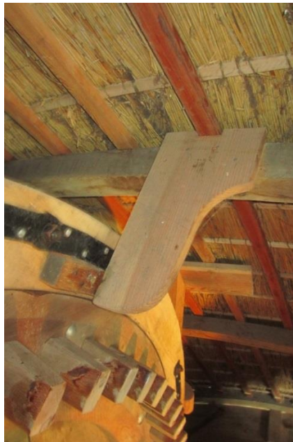
Afb.10 Vorkstutten voorkomen dat vangstukken naast het wiel schuiven.
