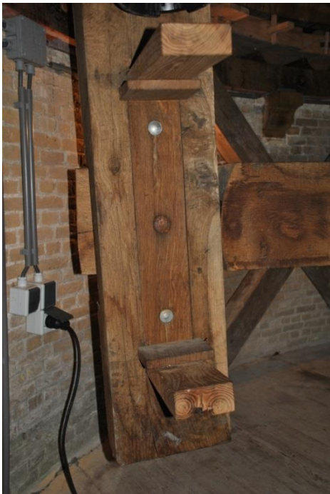
Afb.19 Voorste hanger of ezel met lade of schuif
