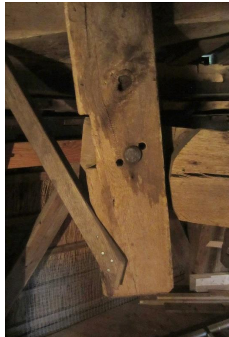
Afb.20 Voorste hanger of ezel met drie gaten en pen De vangbalk is enigszins schuin afgewerkt.
