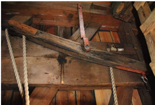
Afb.14 Een evenaar . Hangt naast de rechter steenlijst. Links het vangtouw , rechts de binnenvangketting .
