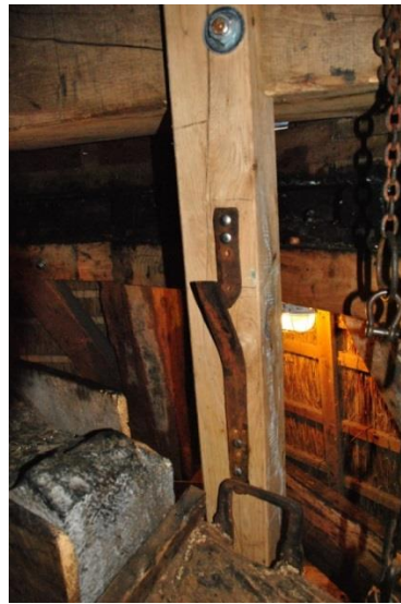
Afb.17 Achterste hanger met duim . Aan de vangbalk de beugel
