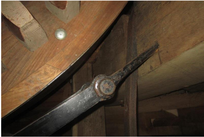
Afb.5 Het vanganker , het vaste punt van een Vlaamse vang of bandvang. Rechts het rechtervoeghout en het sabelijzer . De vang trekt binnenwaarts en omlaag aan het rechtervoeghout.
