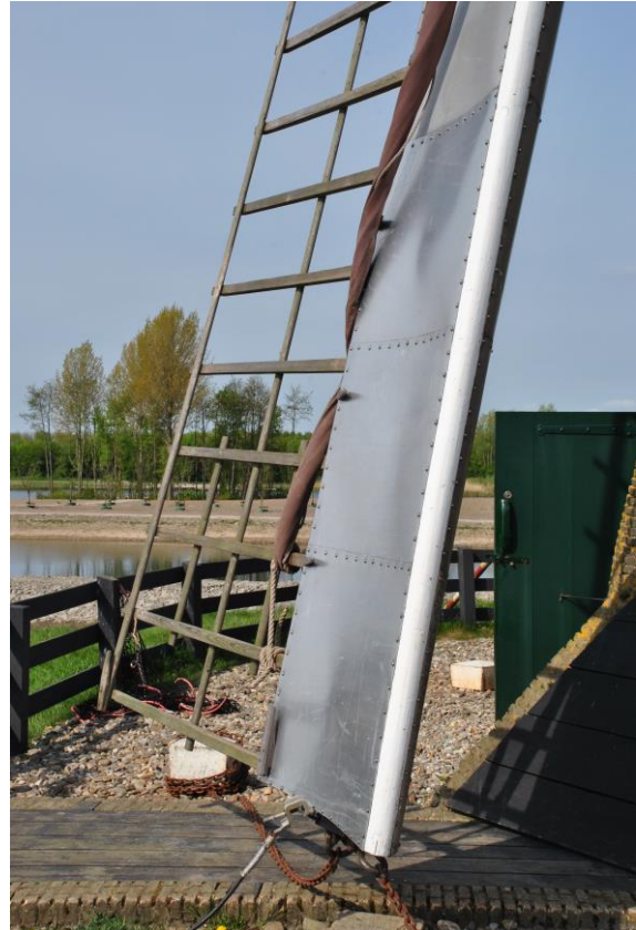
Afb.10 Smaller hekwerk en zeil, de roe is 'ingepakt'.
