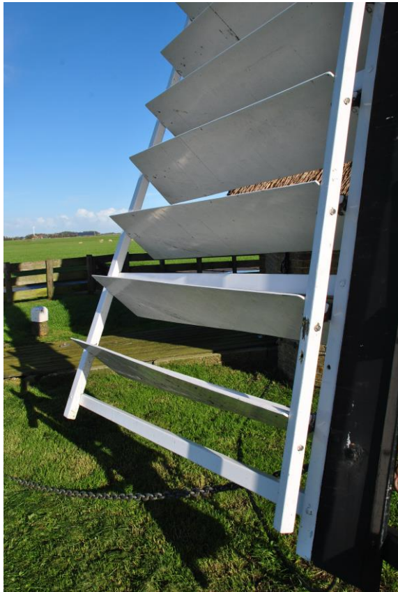
Afb.3 Rechts de treklatt om de klepjes te openen/sluiten.
