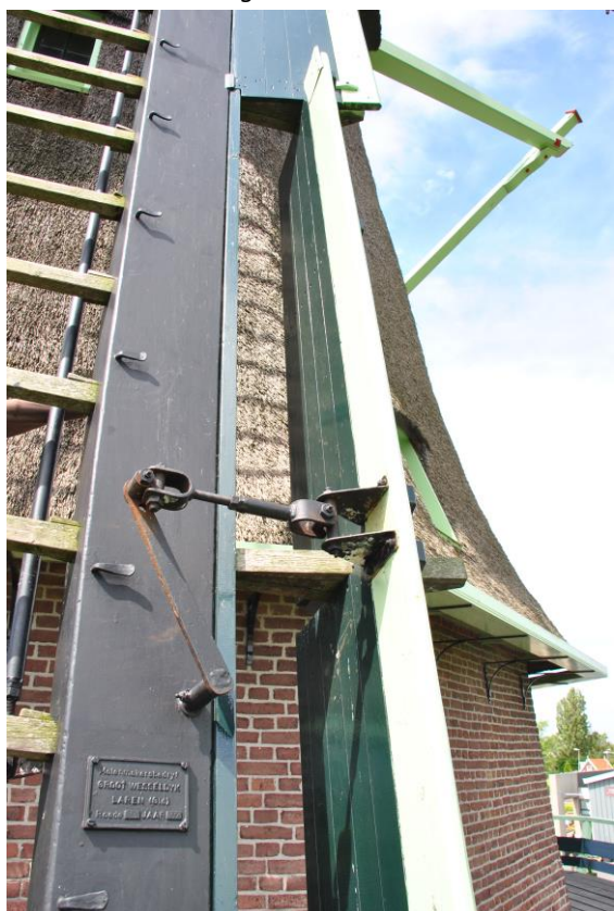
Afb.17 Oud-Hollands gevluht met handbediende remklep. Links naast de roe de bedieningsstang.
