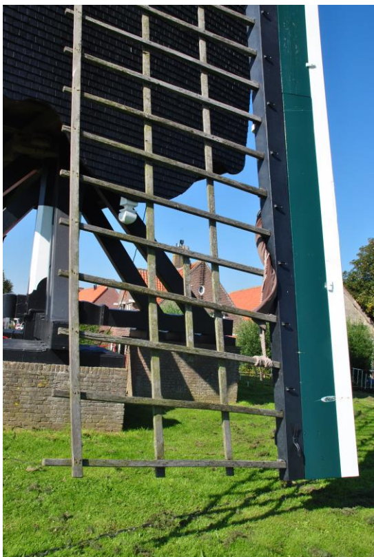
Afb.1 Oud-Hollands: Onderdelen: v.r.n.l. voorzoom (wit), windbord (groen), roede , twee middenzomen met daartussen een zwichtlatje , achterzoom , heklatten ..
