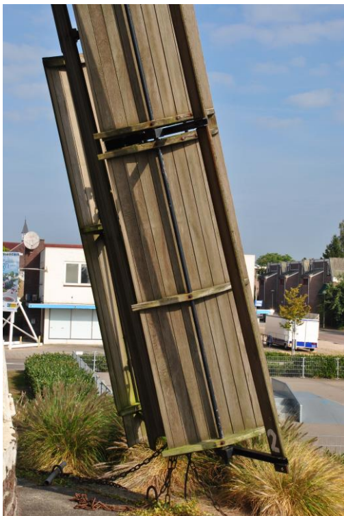
Afb.5 Een geopende Ten Have-klep , links het openstaande regelbord in de fokwiek .
