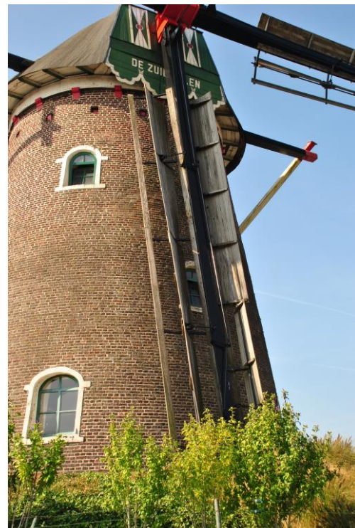
Afb.6 Links van de roe: openstaande Ten Have-klep . Rechts van de roe: fokwiek met geopend regelbord .
