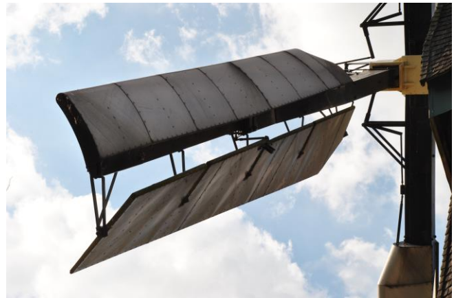
Afb.8 Het Bilau wieksysteem . De klep wordt bediend met trekstangen en een spin .
