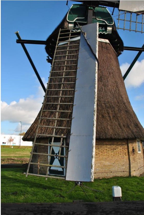
Afb.9 Dekkerprofiel, aan de top hol, bij de askop bol.
