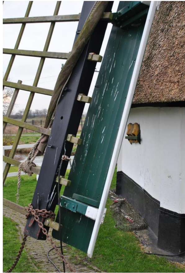
Afb.14 De fok is bevestigd op/aan fokkestoelen en schenkels. Deze fok heeft geen remklep.
