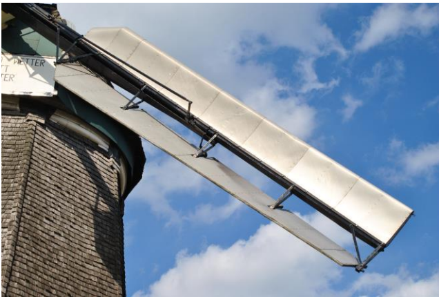
Afb.7 Het Bilau wieksysteem : een stroomlijnprofiel op de roe en een instelbare klep achter de roe
