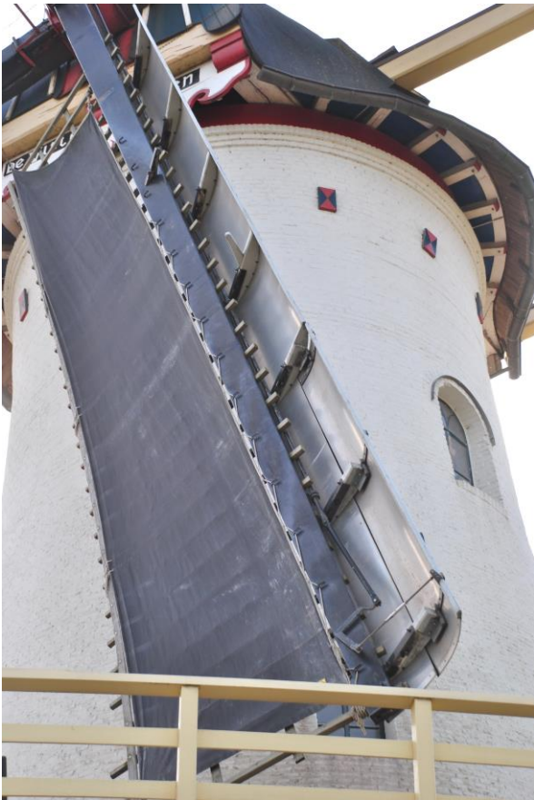
Afb.13 Systeem Fauël / fokwiek met remklep. Zeilklampen aan de voorzijde.
