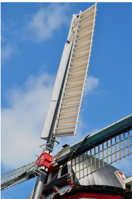
De buitenroede heeft zelfzwichting met Van Bussel stroomlijnneuzen en remkleppen. De binnenroede heeft Oud-Hollands hekwerk en windborden.
