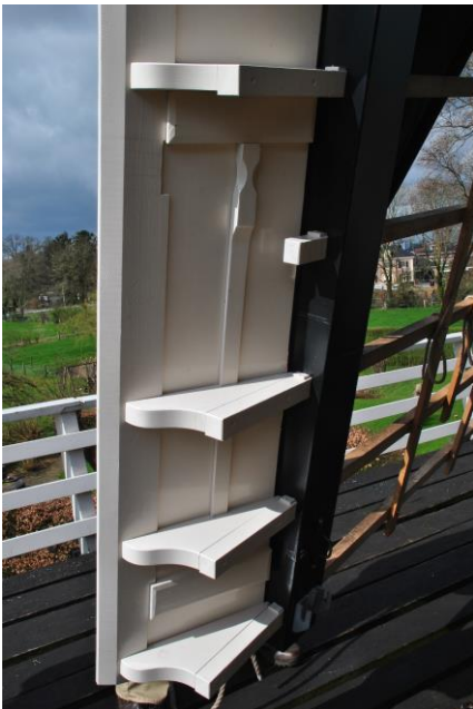
Op de uiteinden van de heklatten zijn kluften aangebracht, waardoor het windbord naar voren steekt. Een bordveer zet het uitneembare stormbord vast.
