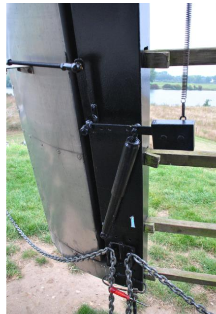
De bediening van een regelbord: hefboom, gewicht, veer en demper. De klepstang ligt achter de roede.
