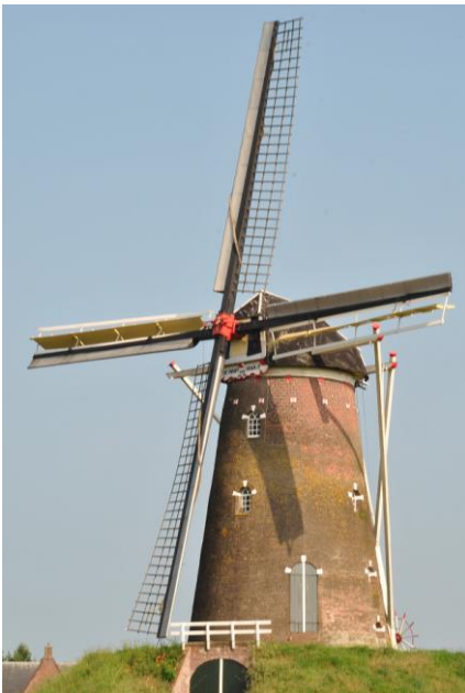
Ten Have kleppen op de horizontaal weggezette binnenroede. Van Busselneuzen op beide roeden.
