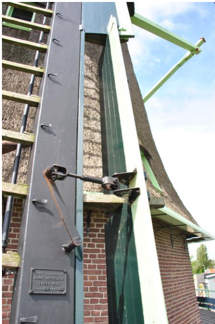
Een remklep in een Oud-Hollandse voorzoom. Links de trekstang voor de bediening.
