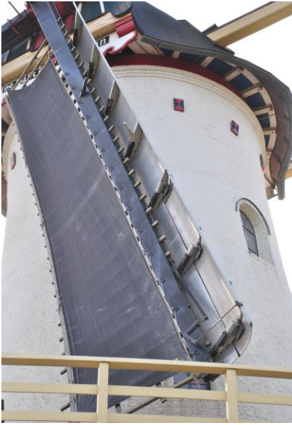
Systeem Fauël of fokwiek. De fok is met schenkels op de roede bevestigd
