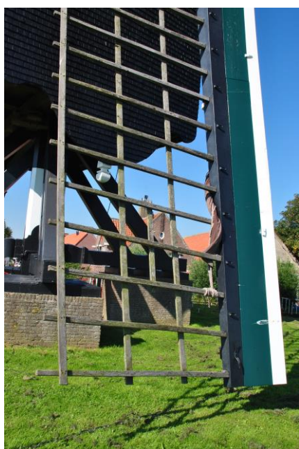
Van rechts naar links: voorzoom, windbord, roede, heklatten, middenzomen, zwichtlatje en achterzoom.
