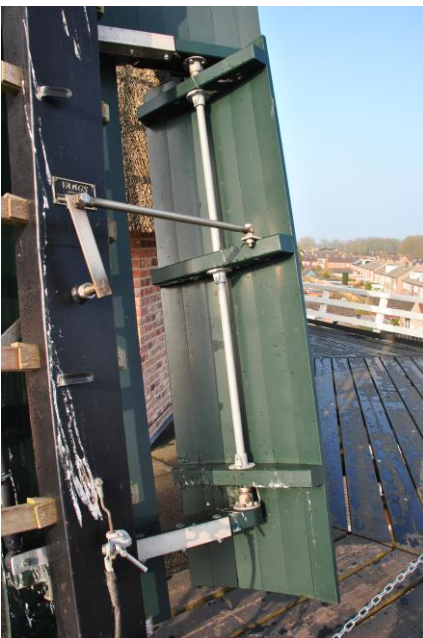
Een regelbord in een fokwiek. De klepstang ligt hier vóór de roede.
