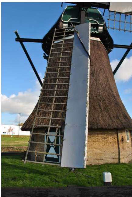
Het Dekker stroomlijnprofiel. Smaller zeil en hekwerk. De roede is 'ingepakt'.
