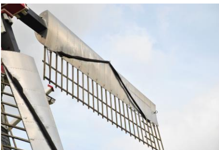
Een Dekker stroomlijnprofiel: hol aan het uiteinde, bol bij de askop. Het hekwerk is versmald.
