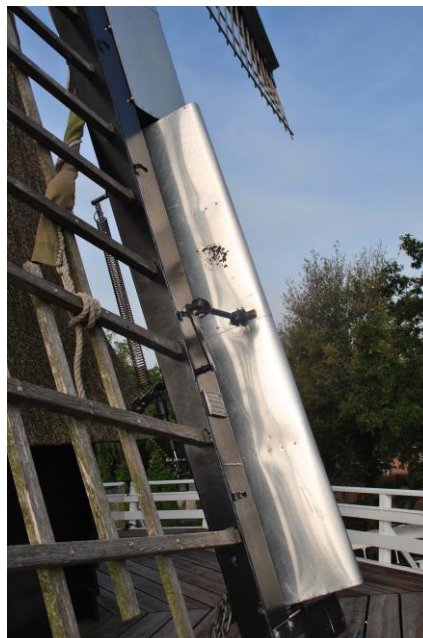
Een regelbord in een Busselneus. De klepstang ligt vóór de roede.
