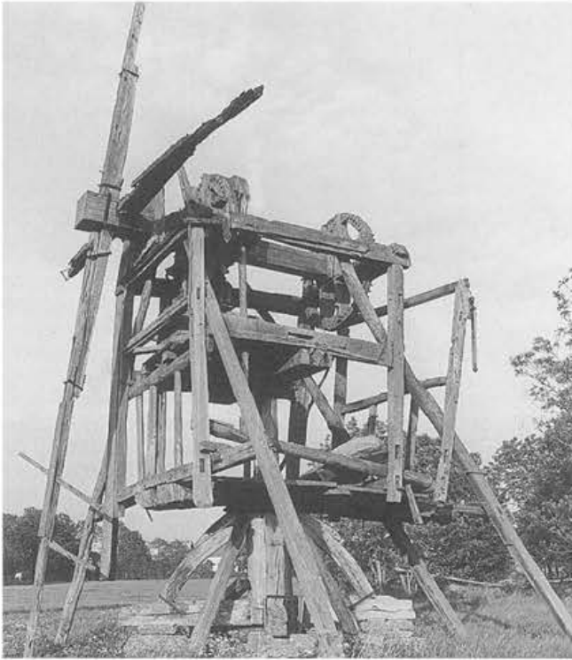
afb. 6: Morby 19-6-1974. Lichte constructie, later verlengd voor de plaatsing van een tweede maalkoppel. Houten as, die bijna horizontaal ligt. Twee bovenwielen. De vaste schoren lopen via de voorzomer en de hoekstijlen door naar de windpeluw. De trapbomen lopen via de (achterste) hoekstijlen door naar de daklijst.
