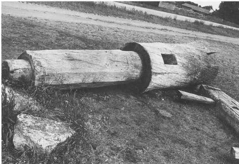
afb. 4: Lerkala 28-6-1974. Op de kraag van de voorbereikte standerd komen de lange burriebalken te rusten (en te kruien). Een zetel is daarom overbodig. Het gat in het dikke gedeelte van de standerd is bestemd voor een steekband.
