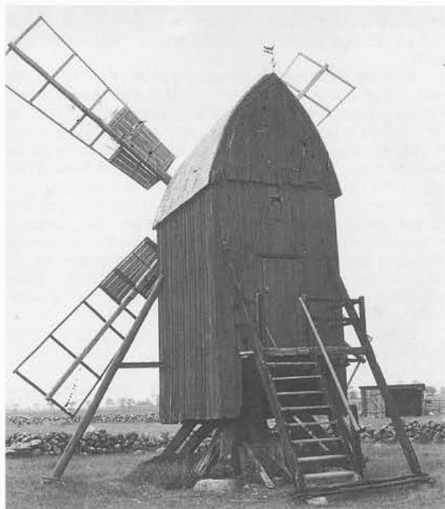
afb. 1: Norrby 22-6-1974. Gebogen puntkop. De trap loopt langs de linkse trapboom en steunt via twee stenen op de grond. De vaste schoren worden extra gesteund door een daartoe verlengde voorzomer.
