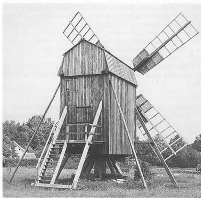
afb. 2: Störlinge 23-6-1974. Evenwijdig lopende trapbomen. Gebroken kap. Vaste schoren aan de gevluchtzijde. Losse schoren aan de staartzijde.
