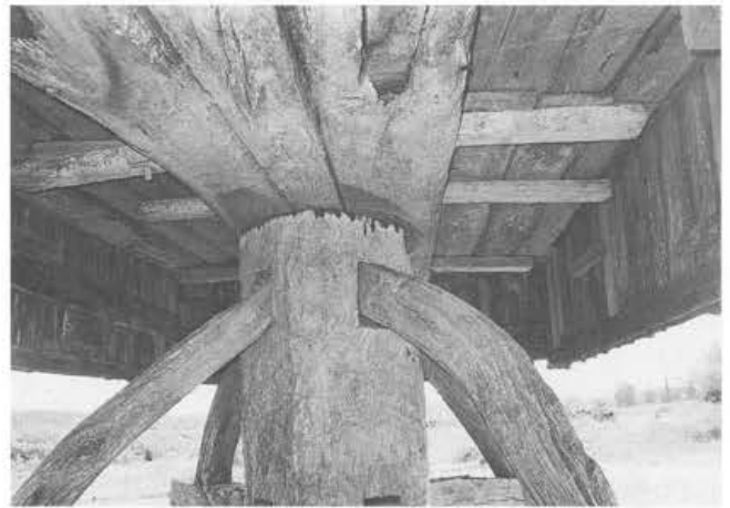
afb. 5: Störlinge 23-6-1974. Vier kromme steekbanden steken in de standerd. De lange burriebalken rusten op de kraag.
