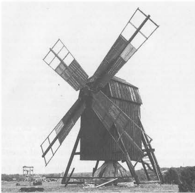
afb. 3: Högsum 20-6-1974. Dwarsgetuigde vliedervieken op houten borststroeden. Houten borden i.p.v. zeilen. Vaste schoren aan de gevluchts- en aan de staartzijde. Op de achtergrond een molen in opbouw.
