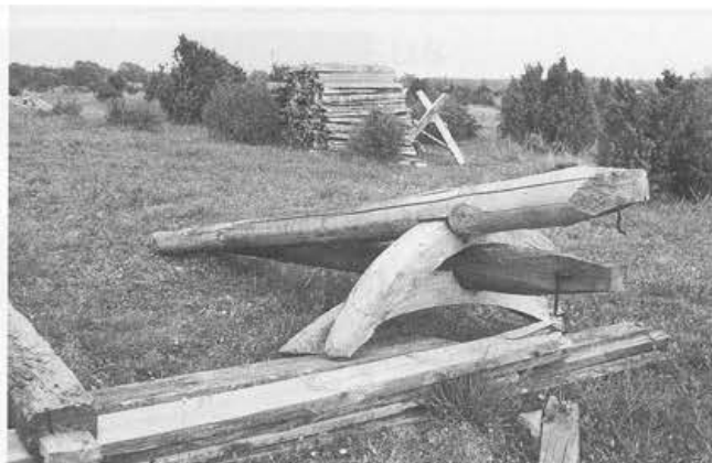
afb. 10: Högsrum 20-6-1974. Een nieuwe vang voor een molen in opbouw. De korte einden van de bedieningsbomen liggen op de windpeluw. Een simpele haak en oog houden ze op hun plaats, waardoor ze wél heen en weer, maar niet van voor naar achter kunnen bewegen.
