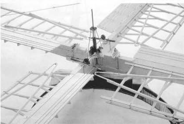
Ballycopeland. Duidelijk zijn de dunne latten van het beweegbare frame, twee geleiders op alle heklatten en halve schuine steunlatten zichtbaar.
