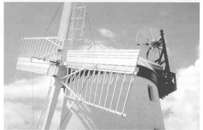
Ballycopeland. De zwichtstang heeft voor de askop een ronde tandheugel met tandwielletjes, korte asjes en rechte tandheugels naar de triangels, die hier afgekoppeld zijn. Foto 15 juni 2002.
