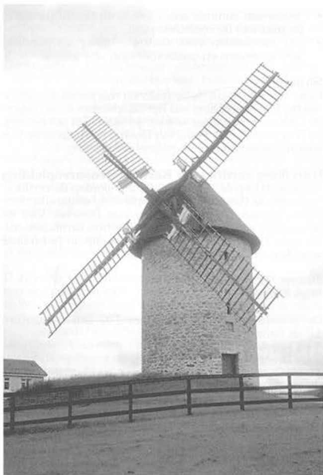
De torenmolen van Skerries met de dwarsgetuigde wieken. Foto 13 juni 2002.
