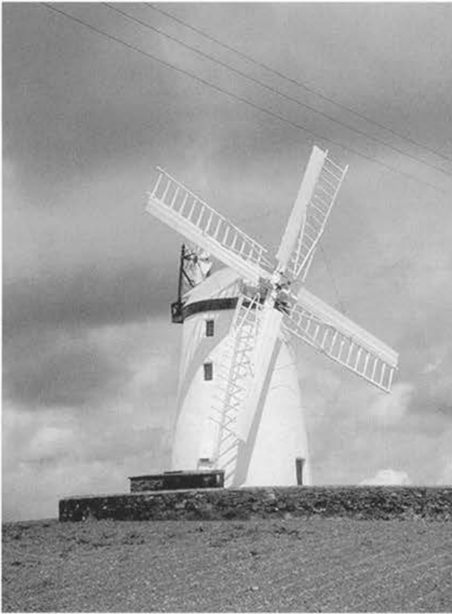
Ballycopeland. De zwichtstang heeft voor de askop een ronde tandheugel met tandwielletjes, korte asjes en rechte tandheugels naar de triangels, die hier afgekoppeld zijn. Foto 15 juni 2002.
