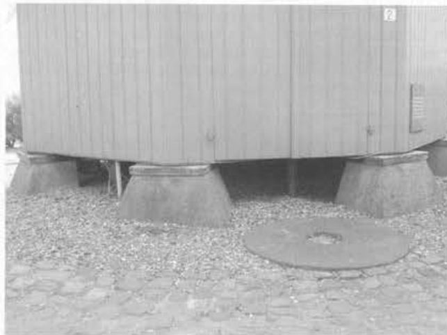
Typisch voor Zeeland, kleine grondzeiler molens geplaatst op acht teerlingen
