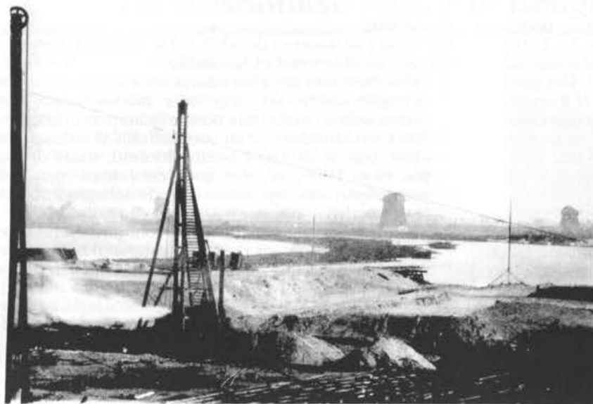
Foto 1. 1890. Bouw van de keersluis tussen het Amsterdam-Rijnkanaal en de ringvaart van de Watergraafsmeer. Unieke foto van de (reeds onttakelde) driegang schepschijf-molens. Foto: Rijksdienst voor de Monumentenzorg.
