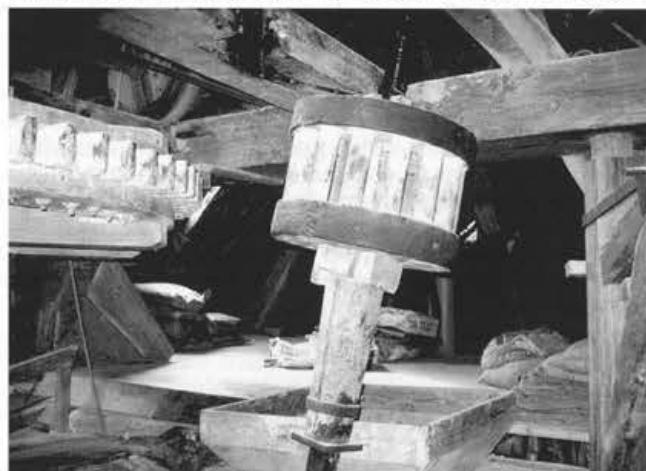
Kijkje bij het maalkoppel met het steenrondsel uit het werk gezet.
