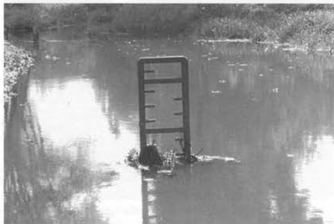
Een heel bijzondere uitvoering van de pegel die de maximale stuwhoogten van het maalwater aangeeft.
