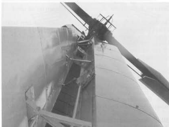
Het Bilau-gevlucht met kleppen, stroomlijnneus en regelstangen.
