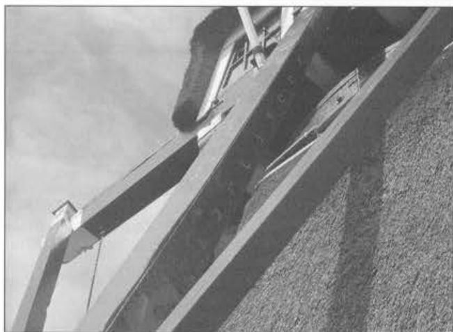
Hergebruik van een oude roede als staartbalk met dichtgepaste hekstokgaten
