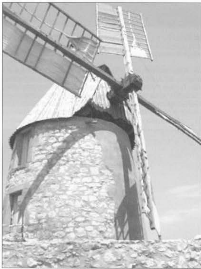
Houten as, houten roeden met staaldraad getuid, ouderwets dwarsgetuid gevluucht met de helft van de zeilen voor en de helft opgerold. De blauwe zeilen schijnen een grapje te zijn. De helft van de romp bepleisterd.
