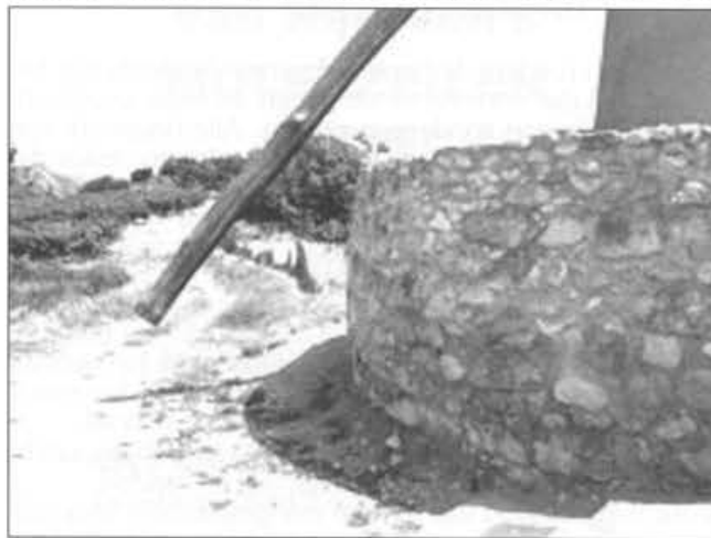
De staart die met een landbouwtrekker wordt rondgezet.
