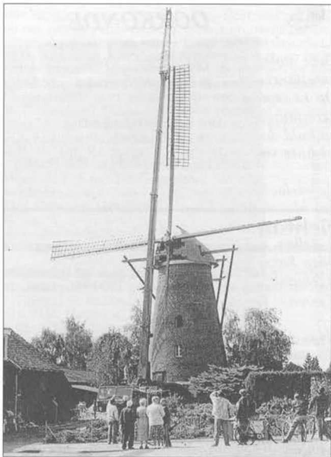
Het steken van de nieuwe roeden, de onderdelen die van een doofpot weer een molen maken
