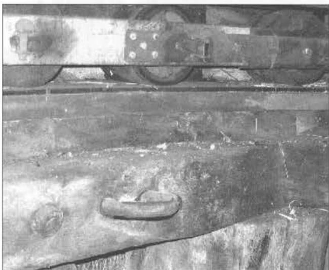
Restant van het binnenkruierwerk. Een kruikram in het boventafelement
