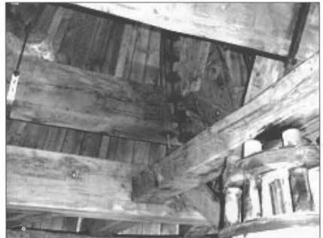
Bovenas en bovenwiel, vangbalk links in de kap met steen verzaard, linker voeghout en roosterhouten die gekeept op de kruiring liggen.
