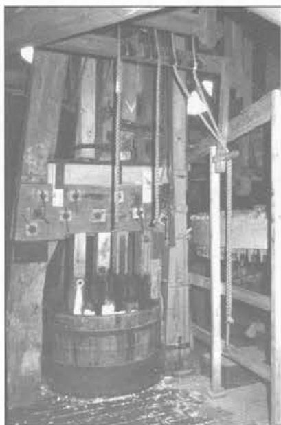
De kapperij met de vier stampers met messen en de roterende kuip
