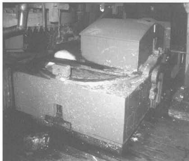
De maalbak of hollander waarin de heel- of halfstof wordt vervaardigd
