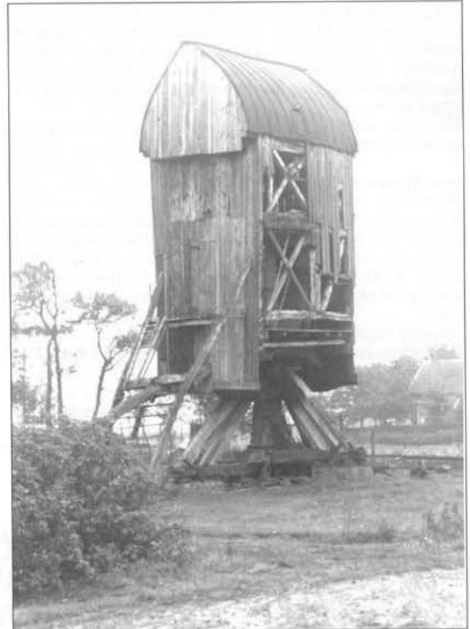
Afb. 2 Mussel 3-8-1941. Niet eerder gepubliceerde foto's. De molen onttekeld, de kast open.
