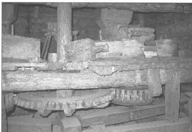
Overzicht van de twee koppel maalstenen met kaar, acht-hoekige kuip, meelpijp, onderaandrijving met spoorwiel en twee schijflopen. De twee pasbalken en de kruisvonder (rechts) zijn goed te onderscheiden.
