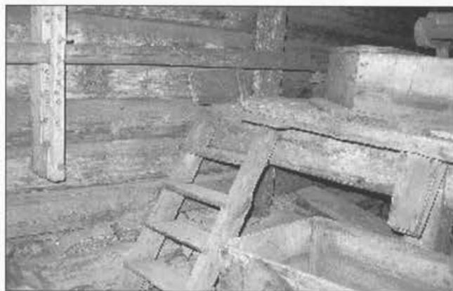
De lichtboom wordt hier (niet traploos) met een pennetje versteld in de geleider.
