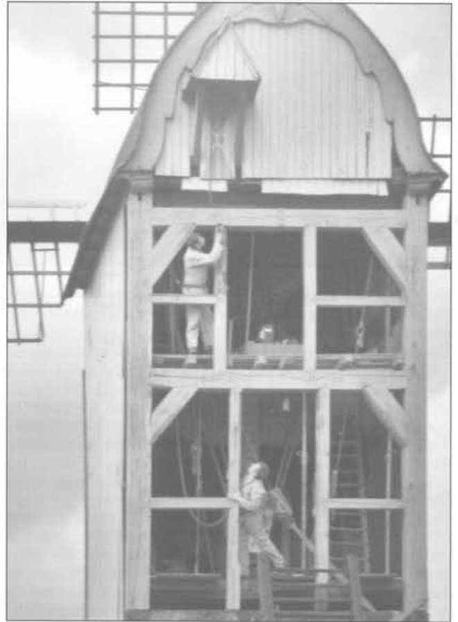
De molenmakers druk doende met de ingrijpende reparatie van het trapbint
