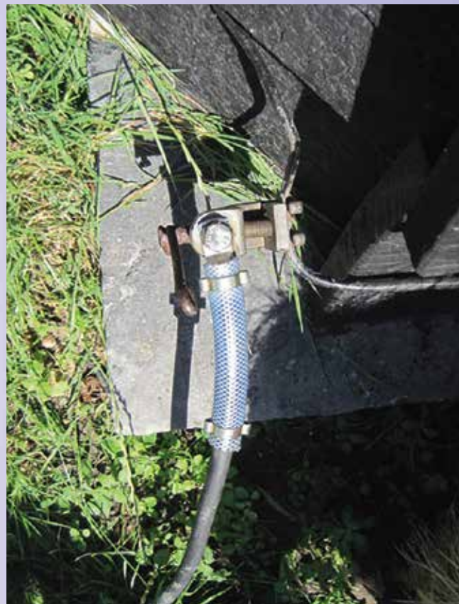
Waterdichte afdichting van de aansluiting op de molenklem. (Foto van Johan Krone)
