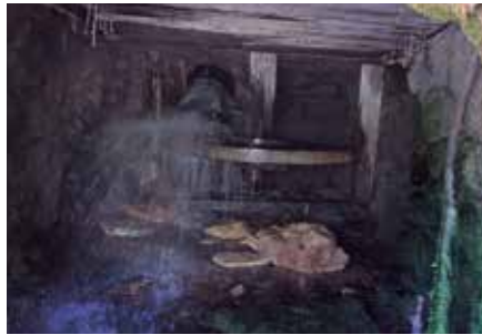
Inkijkje van onderen bij de maalstoel. Het schoepenrad ligt horizontaal. Er spuit geen water tegen het rad aan: vanwege de droogte was er te weinig water c.q. waterdruk
