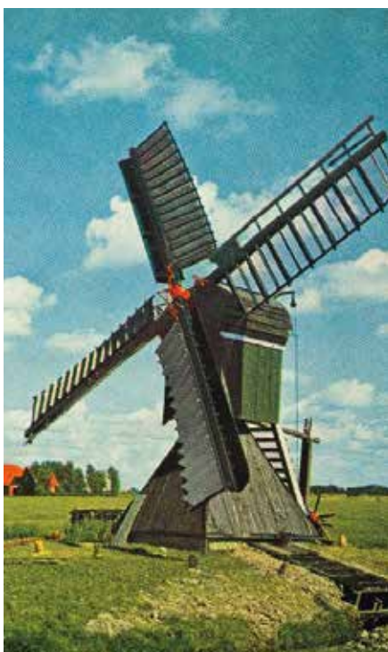
Afbeelding 1: De spinnekop van de polder Fatum onder Tzum rond 1950 met zelfzwiching op beide roeden en fokken op de buitenroede. De spinnekop van de buurpolder had ook op één roede fokken, maar deze molen is in 1958 verplaatst naar de Folkertsloot onder Eernewoude en daar weer voorzien van windborden op beide roeden. (Foto collectie De Hollandsche Molen).
