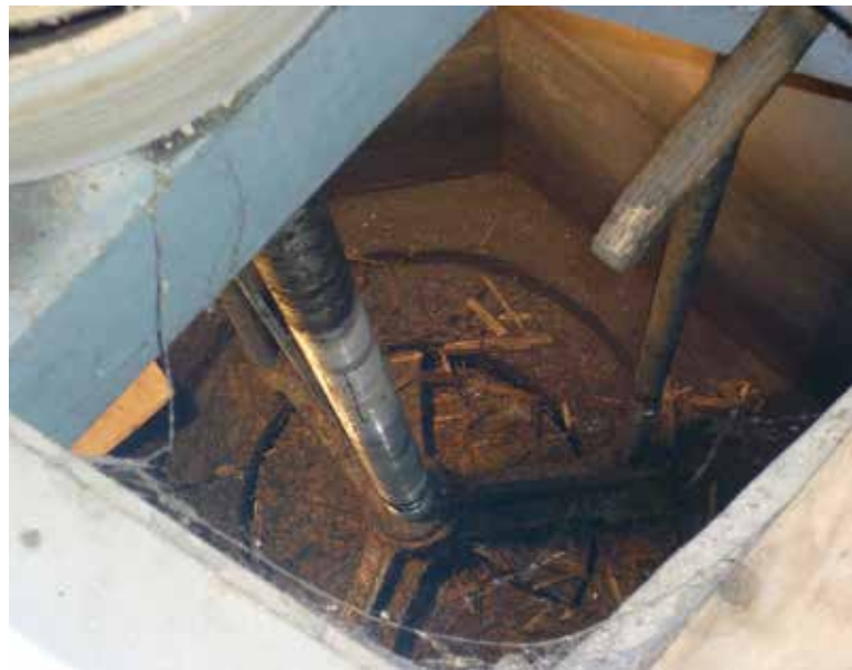
Zicht op een van de pompen
