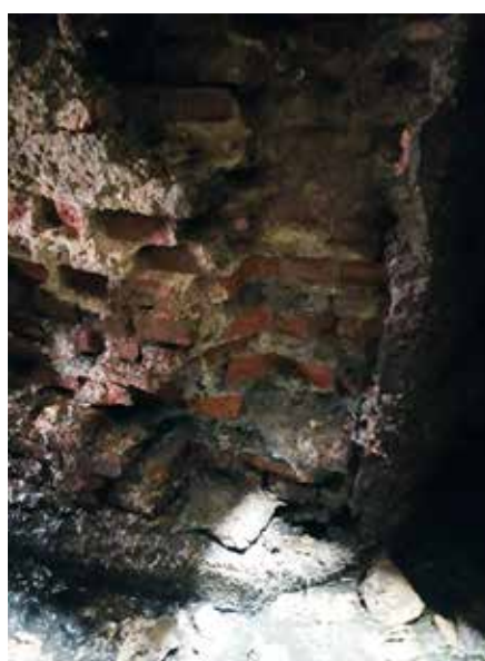
Het slechte metselwerk
