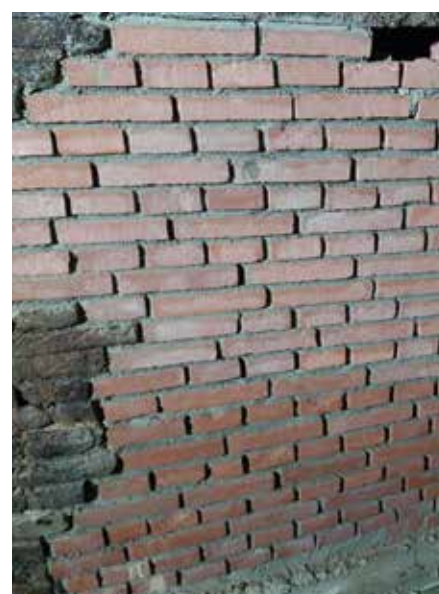
Het metselwerk aangeheeld
