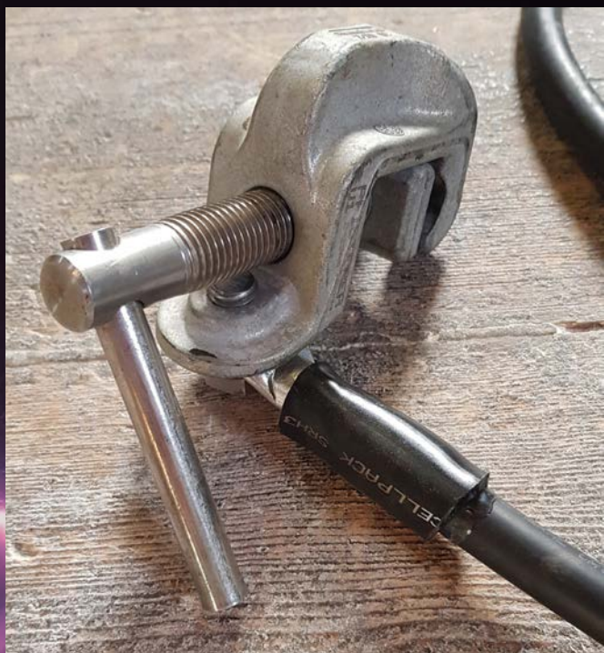
Krimpkous over de aansluiting van de kabel aan de schoen.
