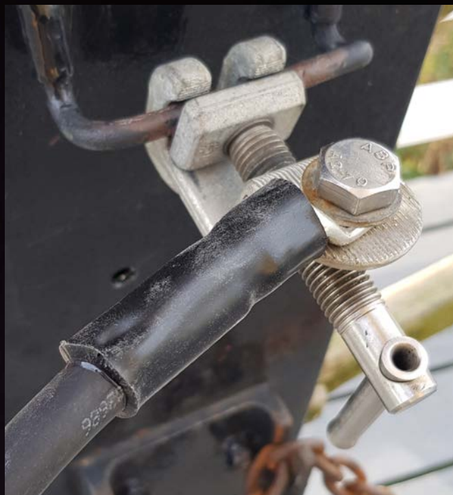
De vernieuwde kabel aan de roe.
