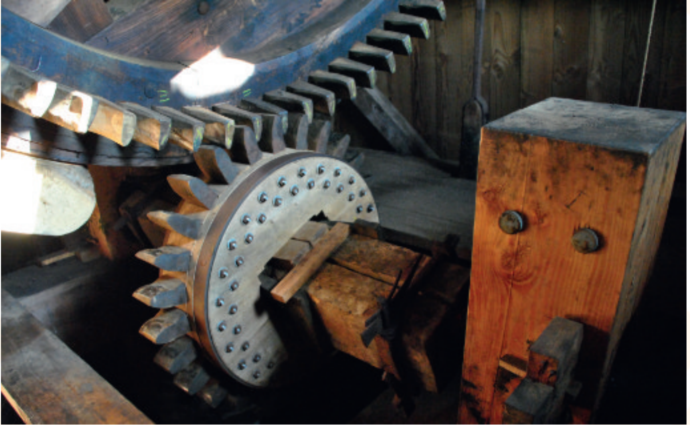
In een paltrok molen ontbreekt de koningspil; het bovenwiel drijft het krukaswiel aan
