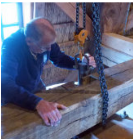
Afb. 7. De steenspil hangt in een kettingtakel.
