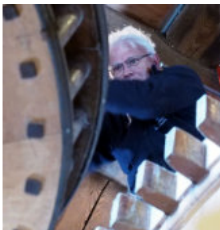
Afb. 8. Het terugplaatsen van rondsel en steenspil.
