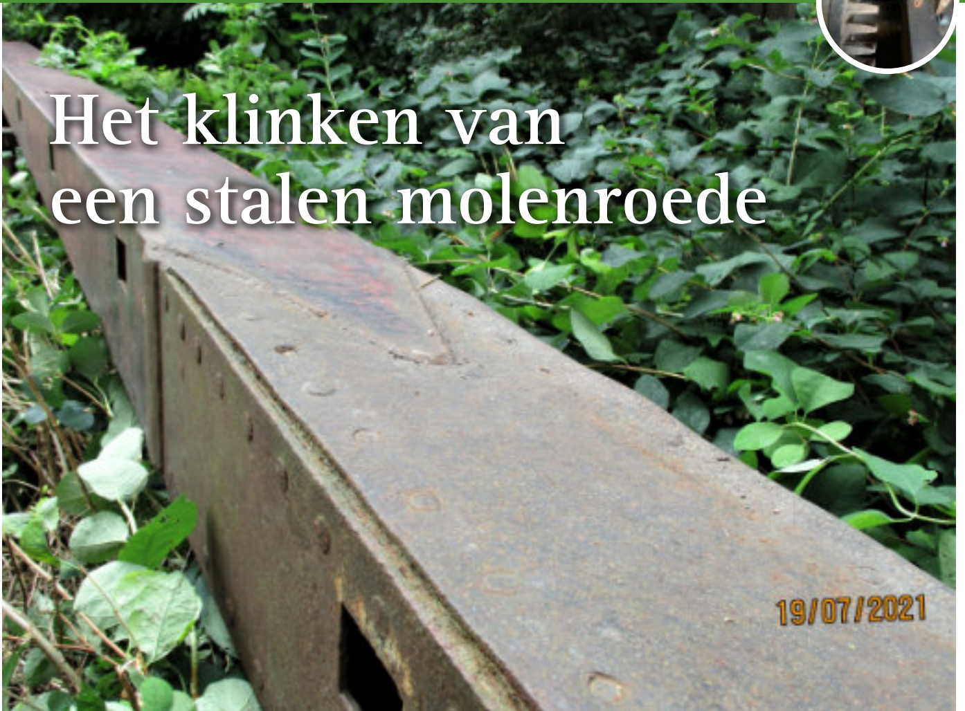
Afb 1. Oude binnenroede. Het middendeel is een Potroede, beide uiteinden zijn later aangelast.
