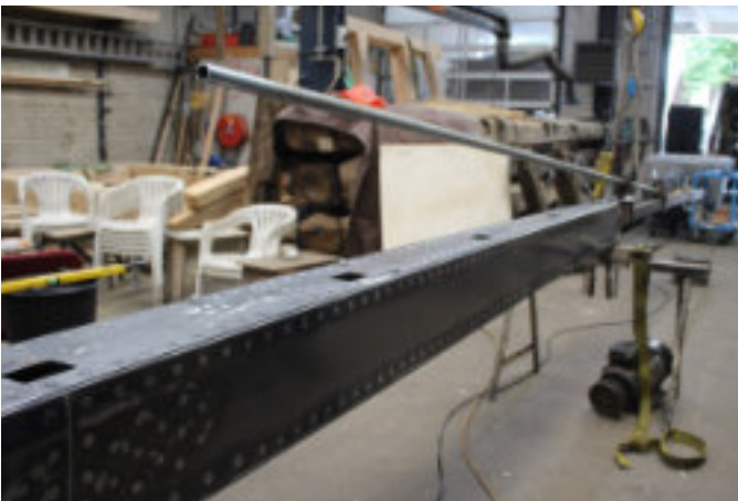
Afb 11. De stuurstang hangt boven de roede. Op de achtergrond is de klinkbalk zichtbaar die in de roede gestoken is. Aan het verre einde van de klinkbalk hangt het gewicht dat de klinkbalk in de roede omhoog duwt.
