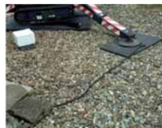
Afb. 4 Bliksemkabel aan de hoogwerker
