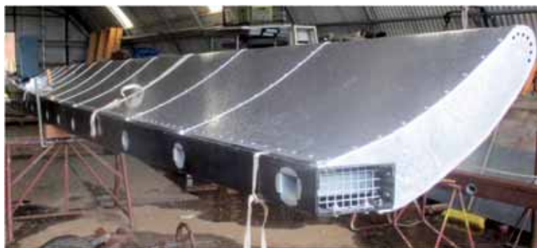
Afb. 6. De beplating is over de profielen gebogen en vastgezet. De koker van profielen en platen kan in z'n geheel worden afgenomen om de roede door de askop te kunnen steken.
