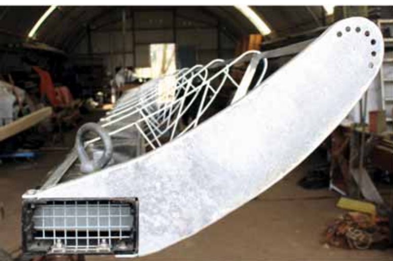
Afb. 5. Detail van het Bremer-profiel aan het eind van de roede. De profielen dragen de hele constructie van de koker. Schenkels, kluften of scheerhouten zijn niet aanwezig.
