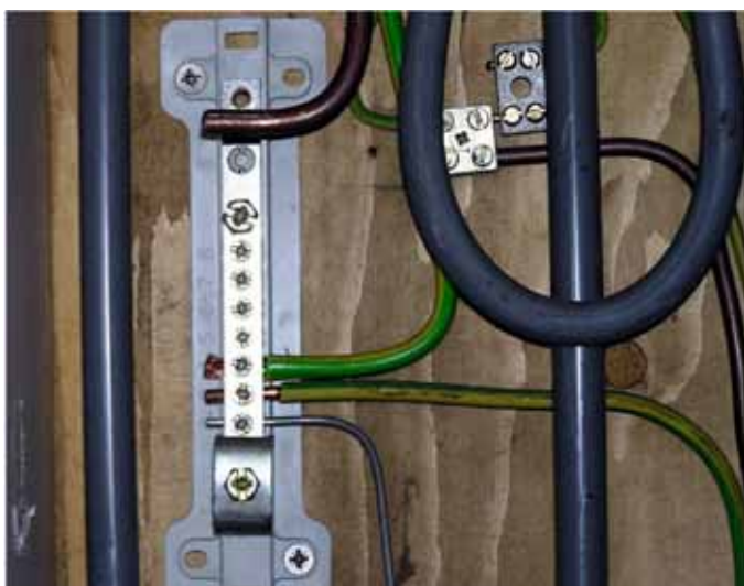
Foto 1. Op deze foto van een potentiaalvereffening zie je links boven een dikke, massief koperen leiding. Dit is de verbinding die naar de bliksemafleider loopt. De andere draden gaan naar de groepenkast, de waterleiding (en indien aanwezig de droge blusleiding en de persluchtleiding). Let op: Toen de foto genomen werd, zat deze koperen leiding niet vast. Dit was nodig tijdens de controle van de installatie. Normaal zit deze leiding natuurlijk wél vast.
