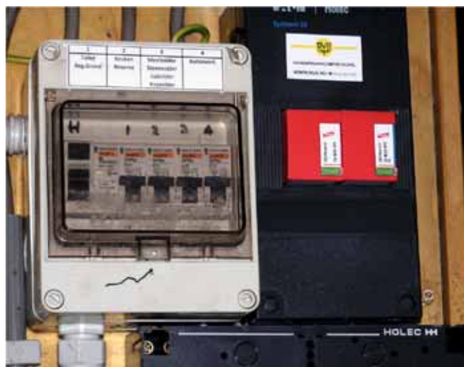
Foto 2. Links een groepenkast met zekeringen en rechts in het rood een overspanningsbeveiliging .
