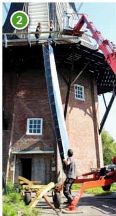
Bij het ophijzen is de binnenzijde van de koker goed zichtbaar
