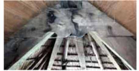
Afb 9. Kaspanten zijn onder de nok gekoppeld door een klamp
