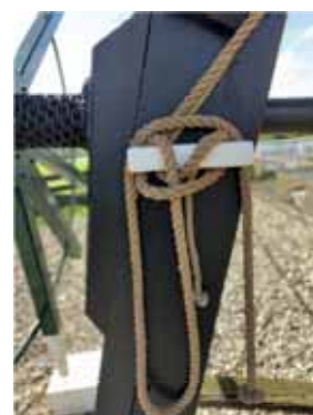
Afb 6. Klamp om het kneppeltouw en het vangtouw op te beleggen.
