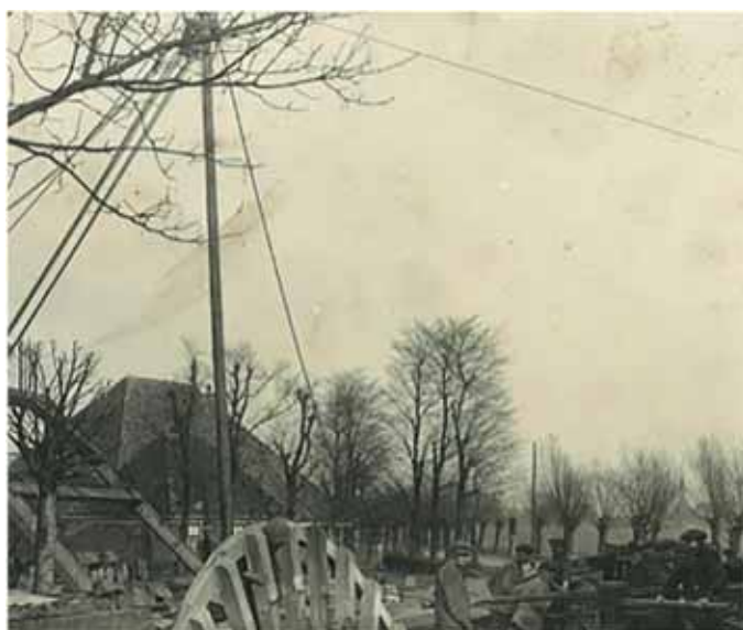
Twee achtkantstijlen worden omhooggetrokken, rechts onderin de kaapstander
