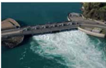
Usine marémotrice de la Rance
