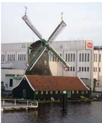
De Ooievaar, Zaandam. Een voorbeeld van een slechte biotoop door bebouwing (foto: Matthijs Ero)
