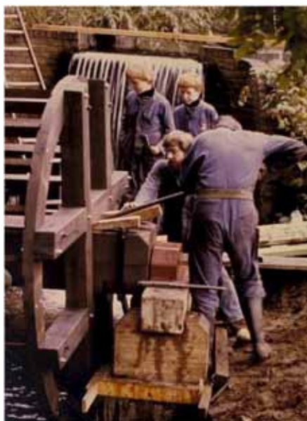
Werkzaamheden aan het rad van de Ruitersmolen
