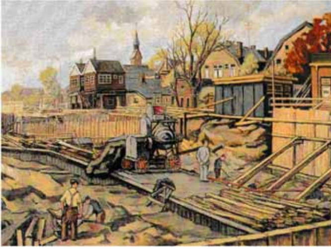
Overkluizing van de Grift in 1977
