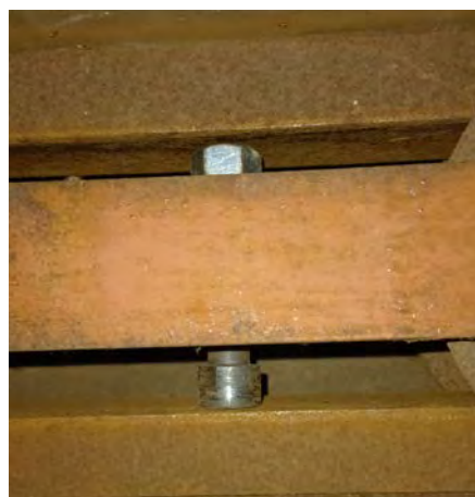
Foto 4 - Bout geplaatst tussen boven- en onderrail
