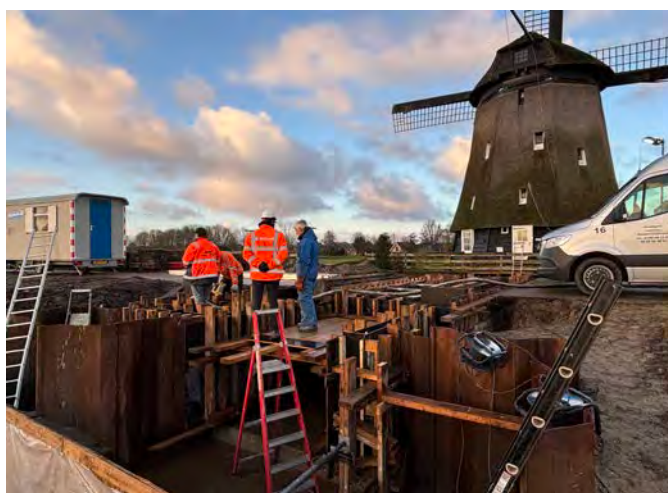
Werkzaamheden herstel voorwaterloop.
