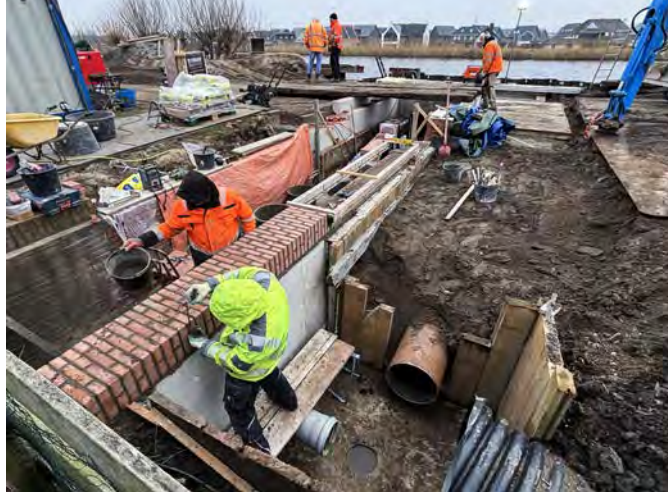
Een buis om water in de polder te laten wordt gekoppeld middels een put aan het oude rondmaalcircuit.
