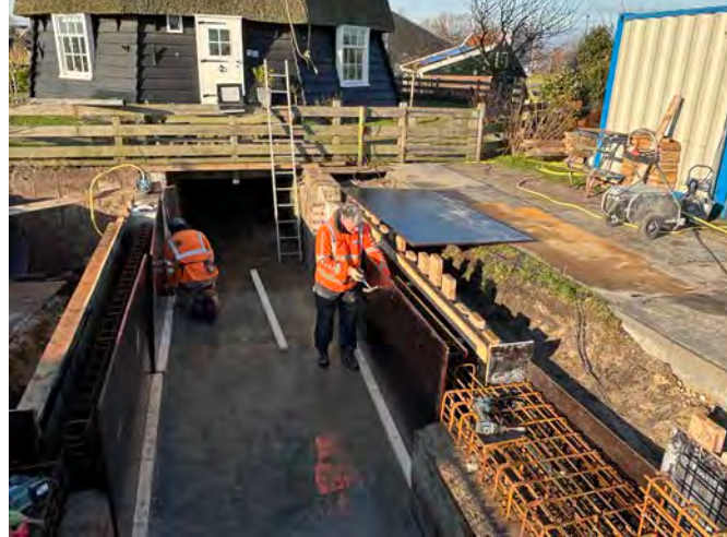
De voorwaterloop wordt voorzien van betonnen damwanden.
