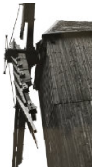
5 – Orville (Beauce), 1973 Met behulp van 5 zwenkhouten per end schuiven de zichtplanken open en dicht. Foto archief SMD.
