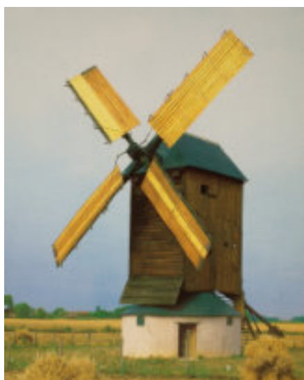
4 – Moulin Gaillardin in Chapelon (Loiret) Standermolen met uitgeschoven Bertongevlucht. Elk end bestaat uit tien in- en uitschuifbare planken. Foto archief SMD
