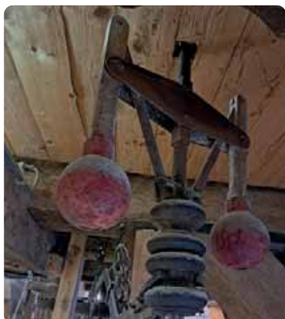
Duwregulateurs Bouwjaar 1816 Verhoging voet in 1852/Gerestaureerd in 1970 Aandrijving via de steenspil
