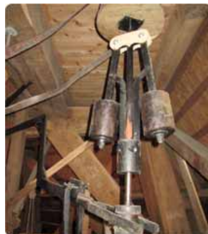
Trekregulateur Bouwjaar 1814 Herbouwd in 1976 Aandrijving via de bolspil
