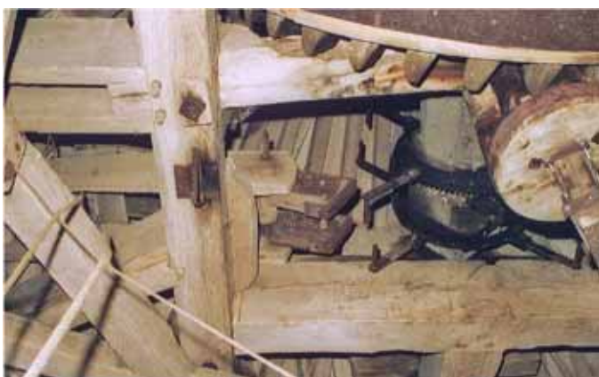
Foto 6: Het kapinterieur in Tillières met links de bedieningsarmen en stuurtoeven
