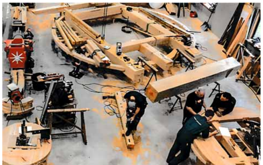
De basis van de kap in aanbouw (foto: Molenbouwer Vaas)
