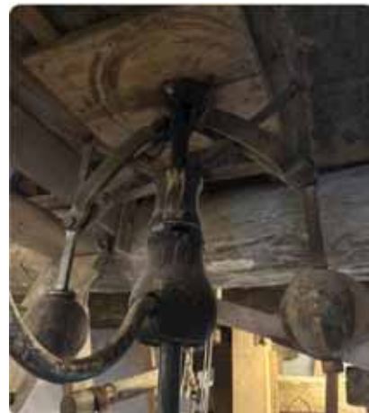
Duwregulateur Bouwjaar 1452 Aandrijving via de koningsspil
