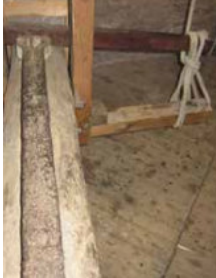
Ballast op de vangbalk
